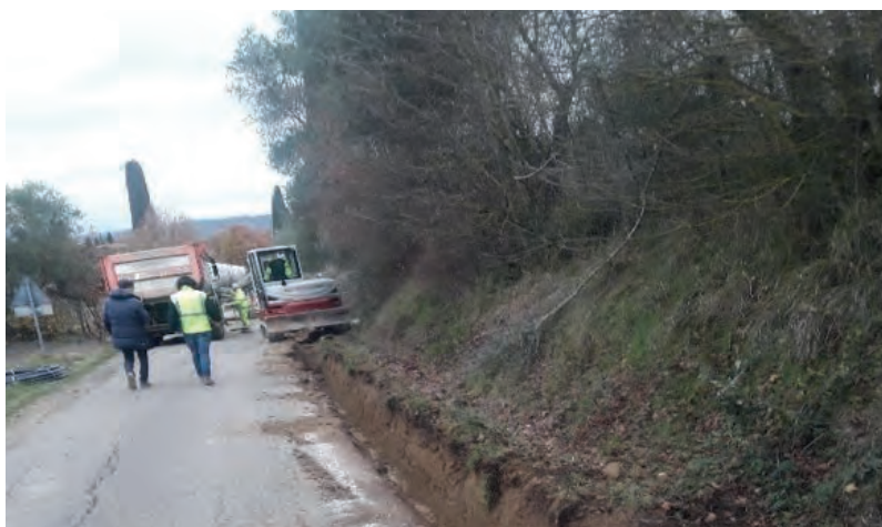
Figura 15: Lavori estensione idrica Loc. Le Selve, Comune di Foiano della Chiana
