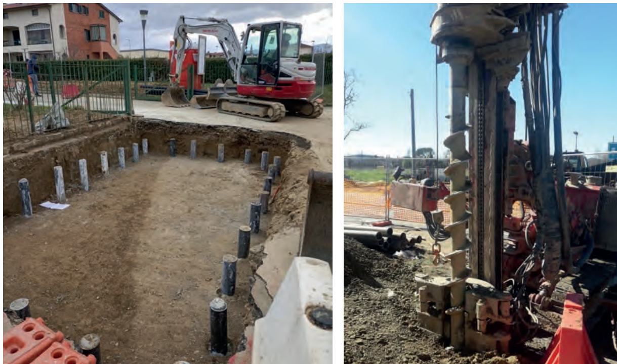
Figura 21: Lavori completamento del collegamento alla depurazione Viale Santa Margherita e Via Buonconte da Montefeltro, Comune di Arezzo
