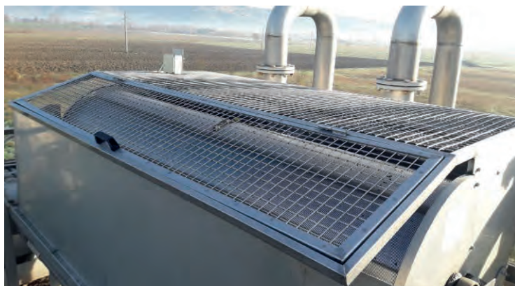
Impianto di depurazione Cortona Monsigliolo: sostituzione del carter di protezione del rotostaccio
