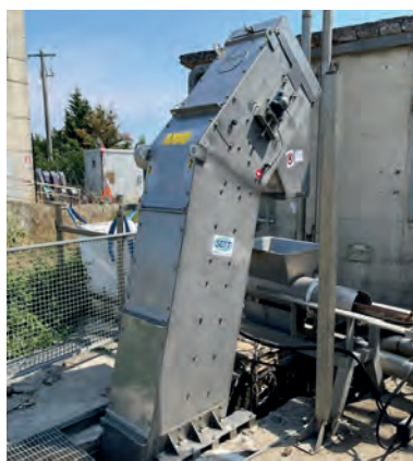
Impianto di depurazione Voltella - Sinalunga: sostituzione delle griglie grossolane
