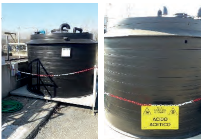
Impianto di depurazione Oreno – Laterina: Adeguamento dello stoccaggio chimico di acido acetico
