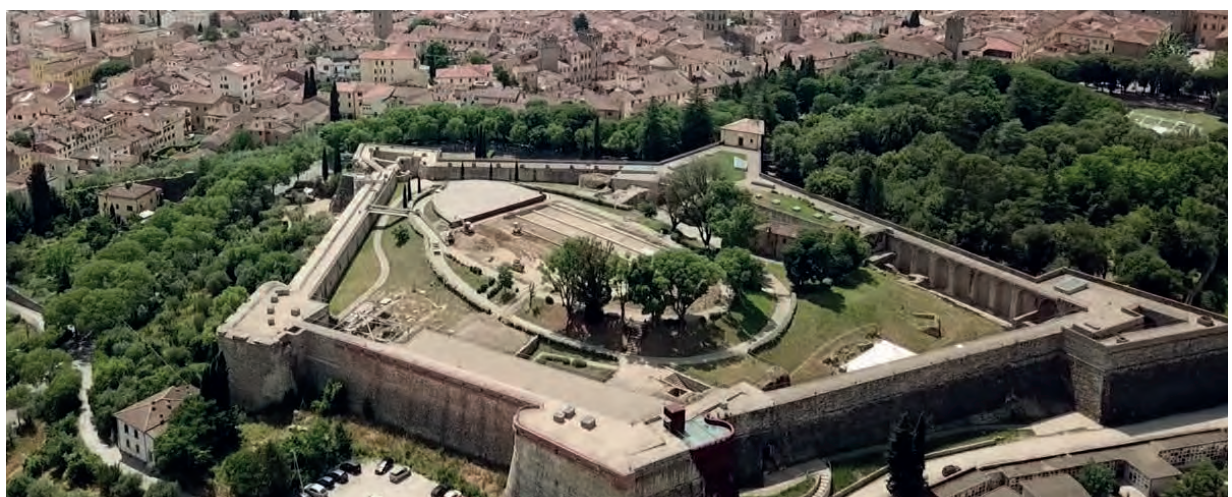
Figura 40: I lavori di ammodernamento del deposito in Fortezza, Arezzo
