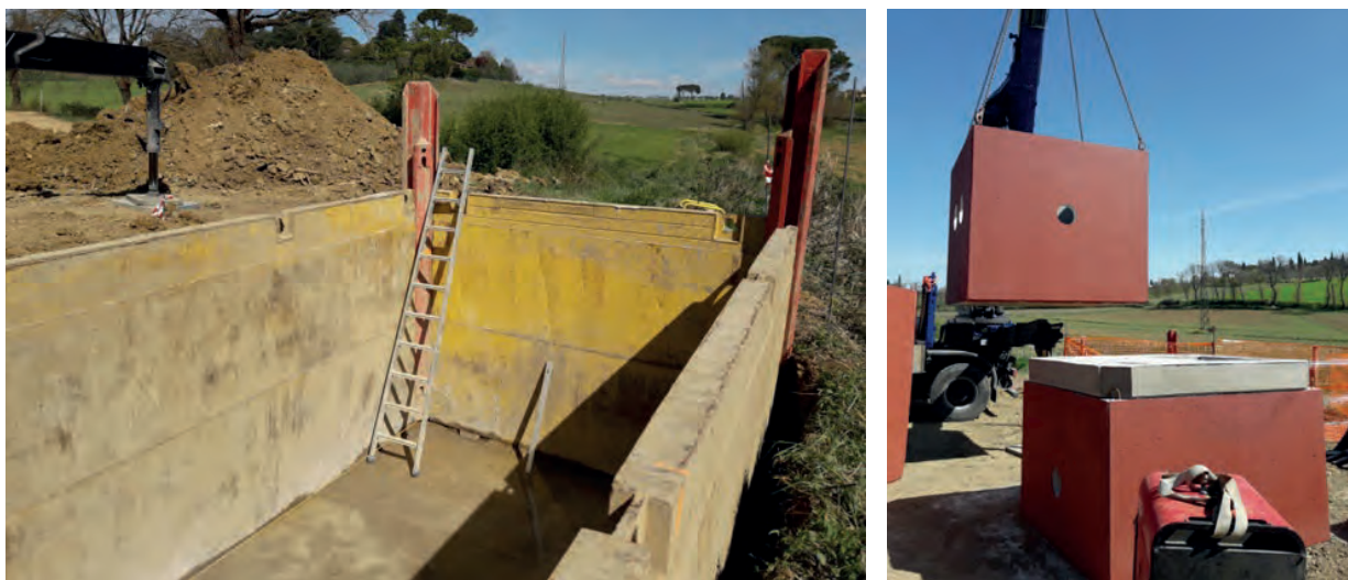
Figura 17: Esecuzione dei lavori di completamento collettori fognari Foiano della Chiana
