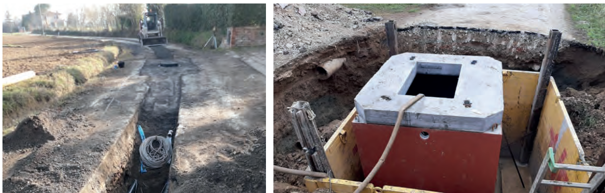
Figura 19: Lavori collettori fognari Loc. Santarello, Comune di Sinalunga
