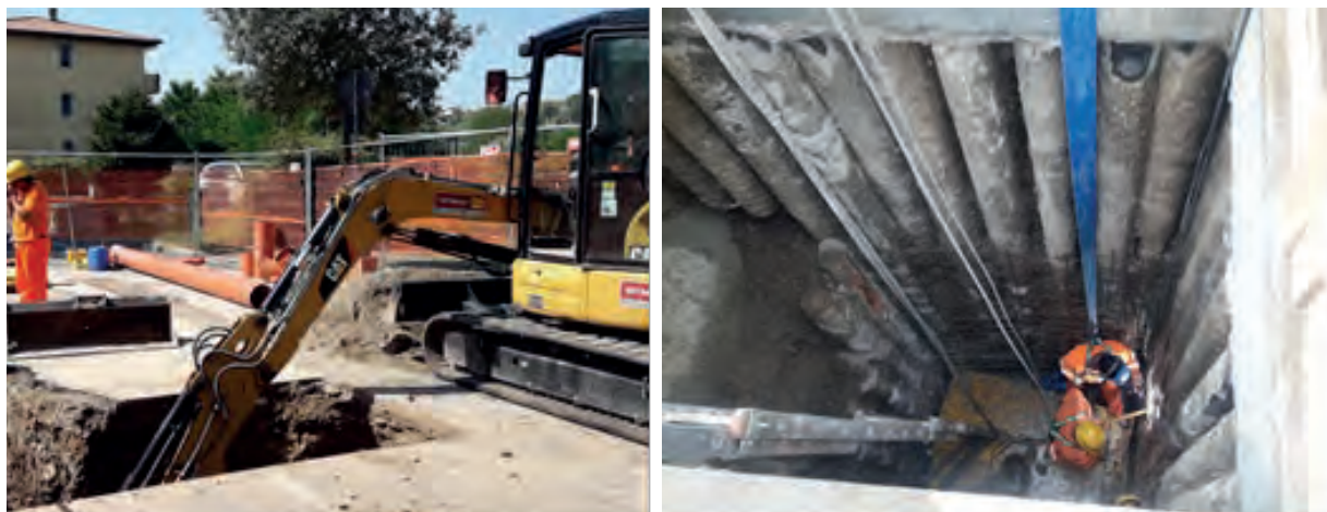
Figura 18: Completamento collegamento alla depurazione agglomerato di Subbiano
