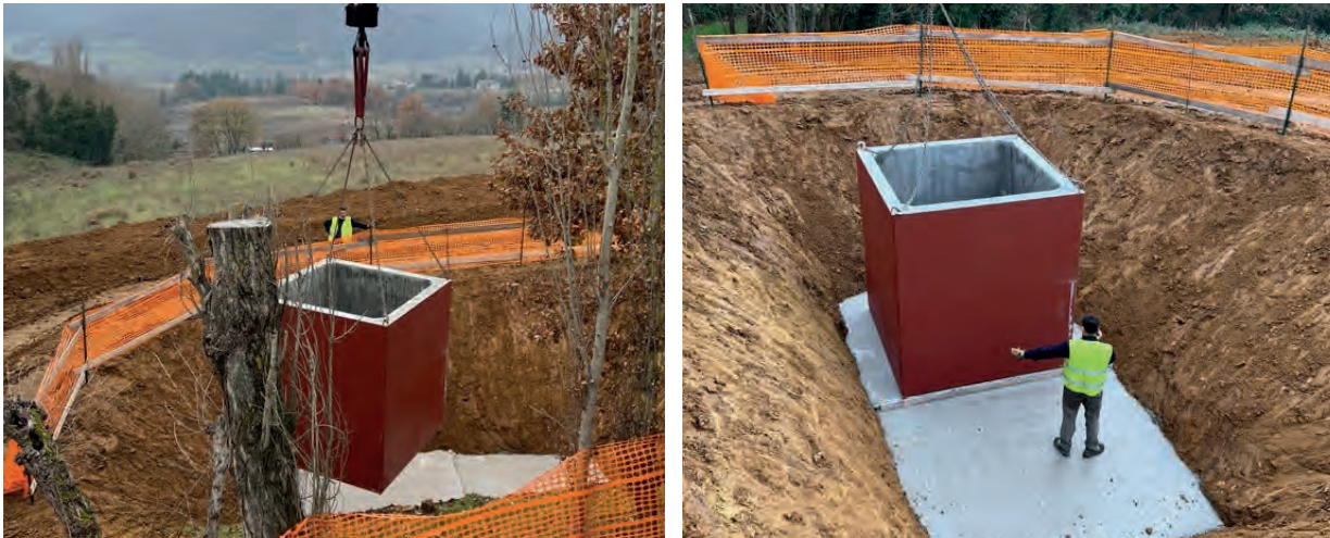
Figura 20: Lavori completamento del collegamento alla depurazione dell'agglomerato di Anghiari
