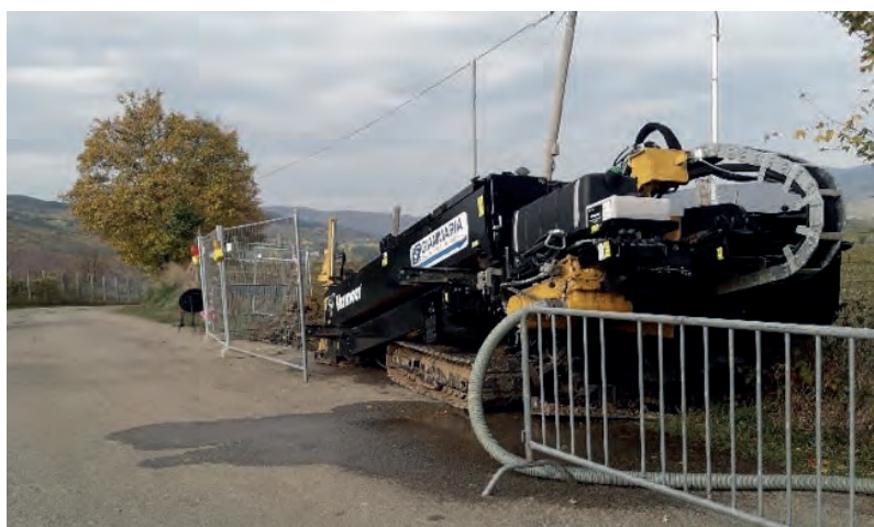
Figura 16: Lavori estensione idrica Loc. San Donato, Comune di Pratovecchio Stia
