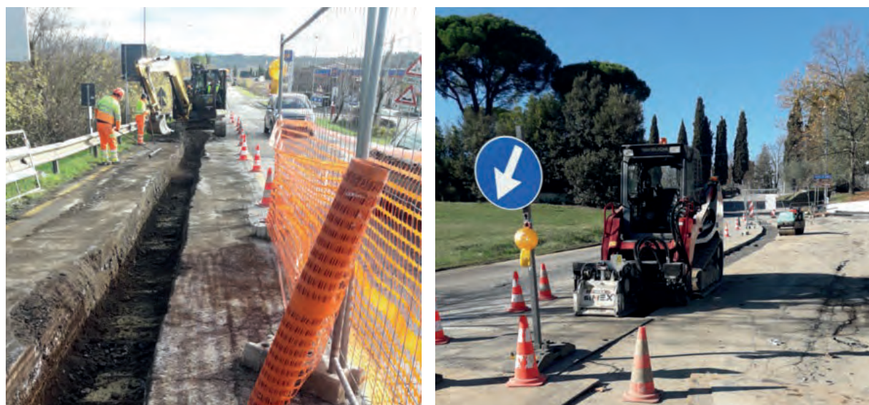
Figura 14: Lavori estensione acquedotto in Loc. Torena, Monte San Savino
