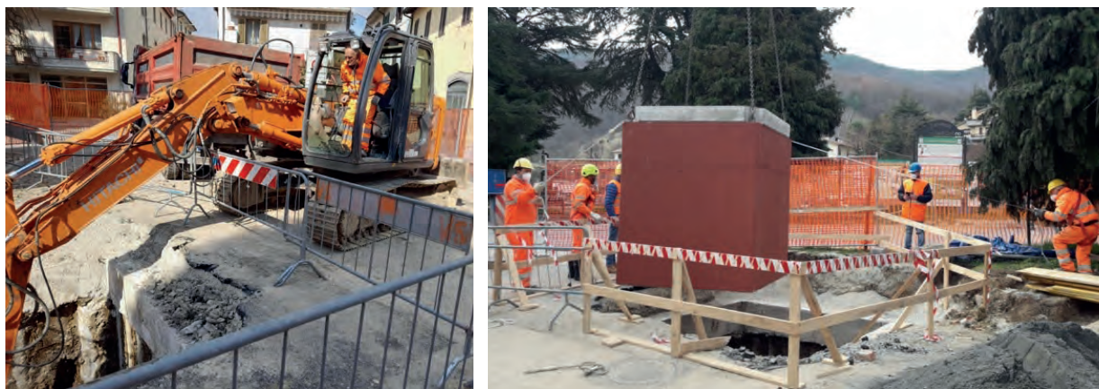
Figura 22: Lavori completamento del collegamento alla depurazione Viale Santa Margherita e Via Buonconte da Montefeltro, Comune di Arezzo
