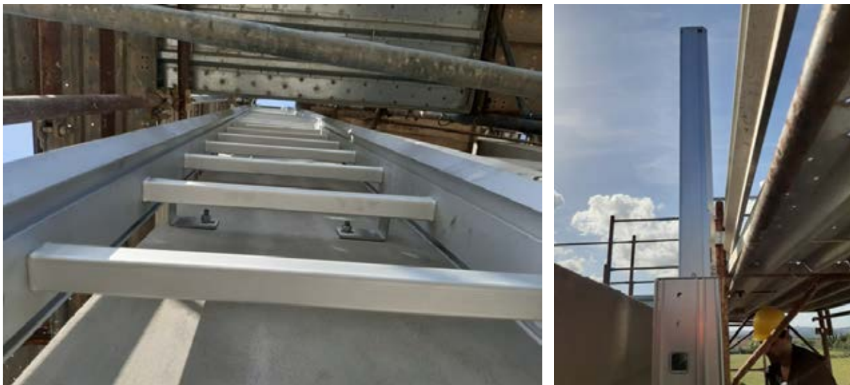
Figura 3: Serbatoio pensile Quarata - realizzazione scala di accesso in quota.
