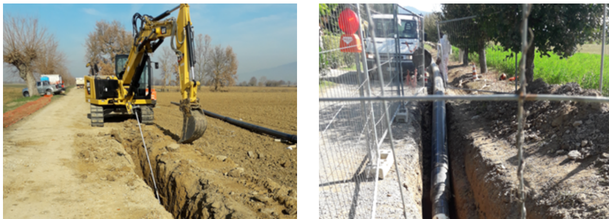
Figura 15: Lavori condotte di adduzione all'impianto di potabilizzazione Belvedere, Comune di Monte San Savino
