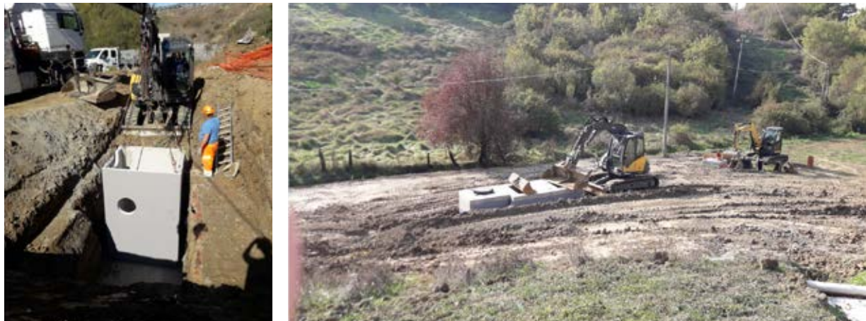
Figura 20: Lavori collettori fognari Ponticino, Comune di Laterina Pergine
