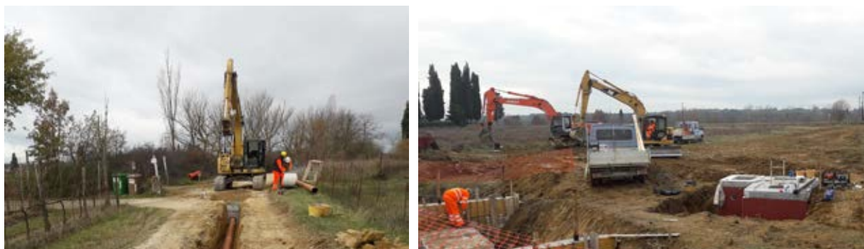
Figura 19: Esecuzione dei lavori di completamento collettori fognari Castiglion Fibocchi
