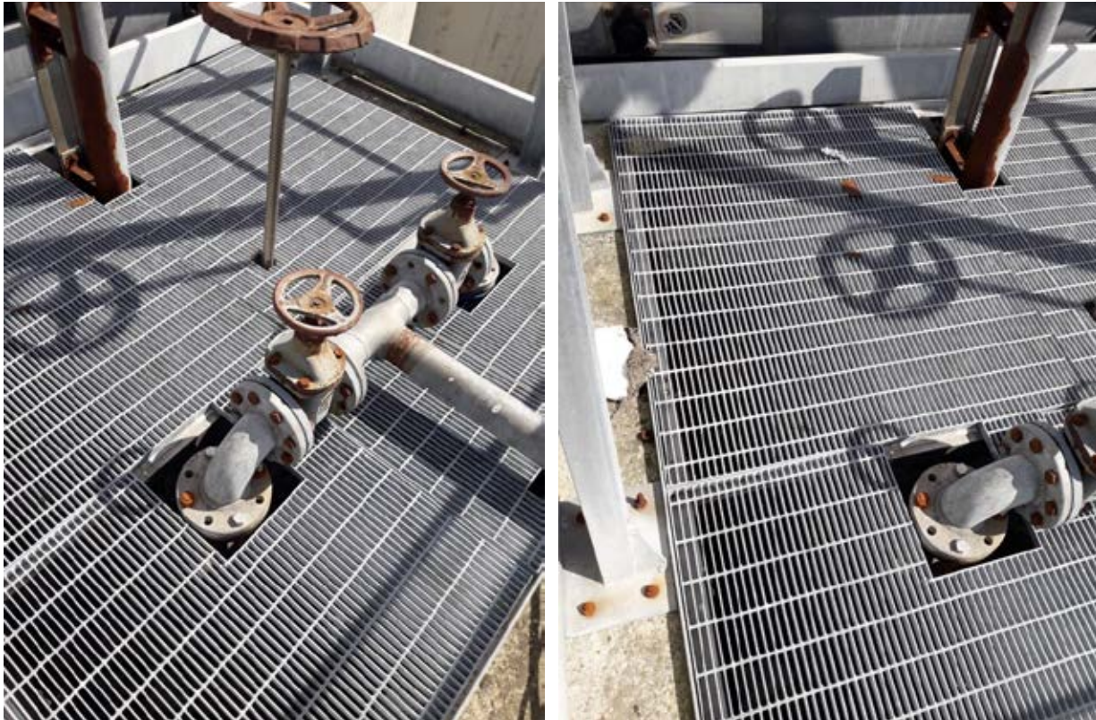
Figura 4: Depuratore San sepolcro - realizzazione grigliati di calpestio
