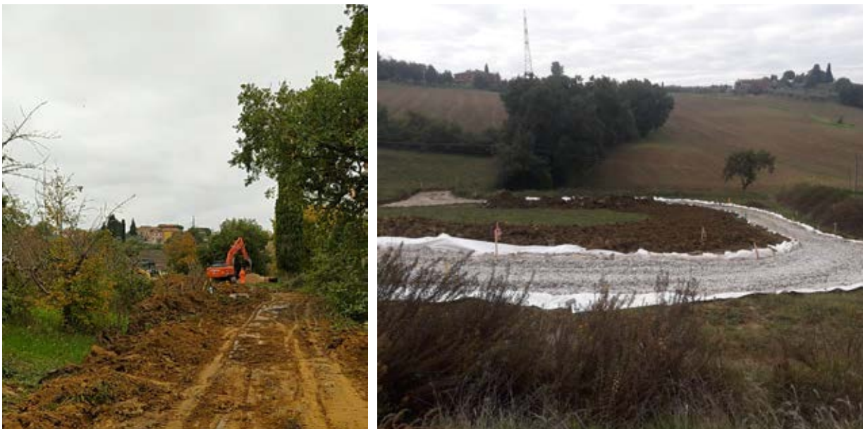
Figura 23: Lavori completamento del collegamento alla depurazione dell'agglomerato di Foiano della Chiana
