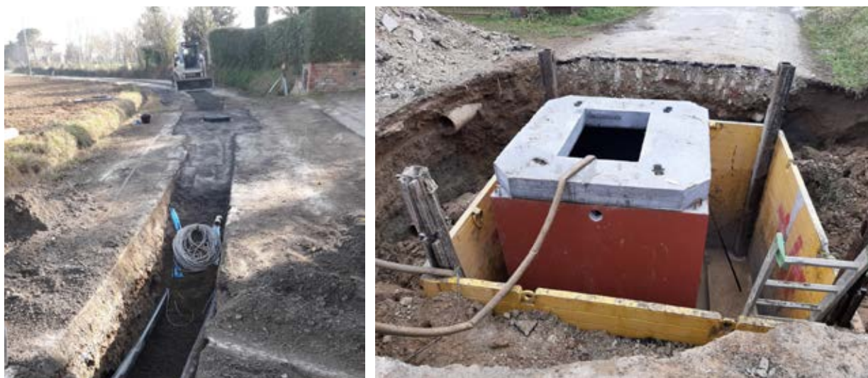
Figura 21: Lavori collettori fognari Loc. Santarello, Comune di Sinalunga
