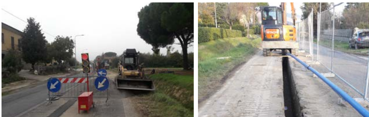
Figura 17: Lavori estensione idrica Loc. Monsigliolo, Comune di Cortona
