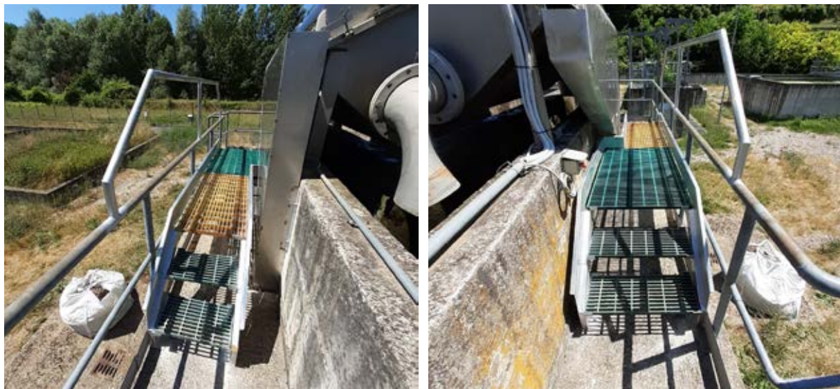
Figura 6: Depuratore Il Termine, Rassina – realizzazione passerella
