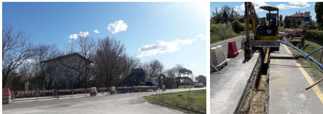
Figura 16: Lavori estensione idrica Via d'Arezzo, Comune di Foiano della Chiana
