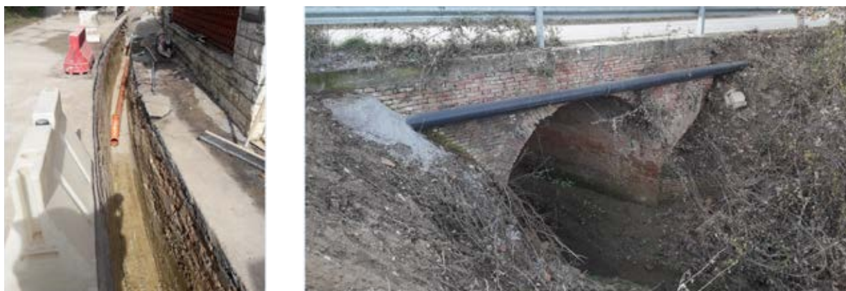
Figura 18: Lavori di estensione idrica e fognaria Località Fonte al Giunco, Comune di Montepulciano
