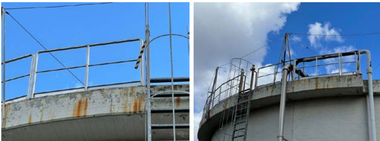
Figura 5: Depuratore Casolino - realizzazione parapetti ex-novo
