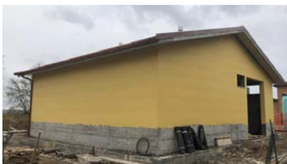
Figura 14: Lavori impianto di potabilizzazione La Macchia, Comune di Montepulciano
