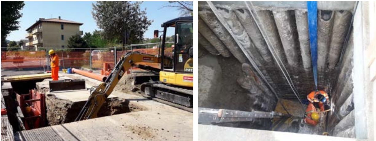
Figura 22: Lavori completamento del collegamento alla depurazione dell'agglomerato di Subbiano
