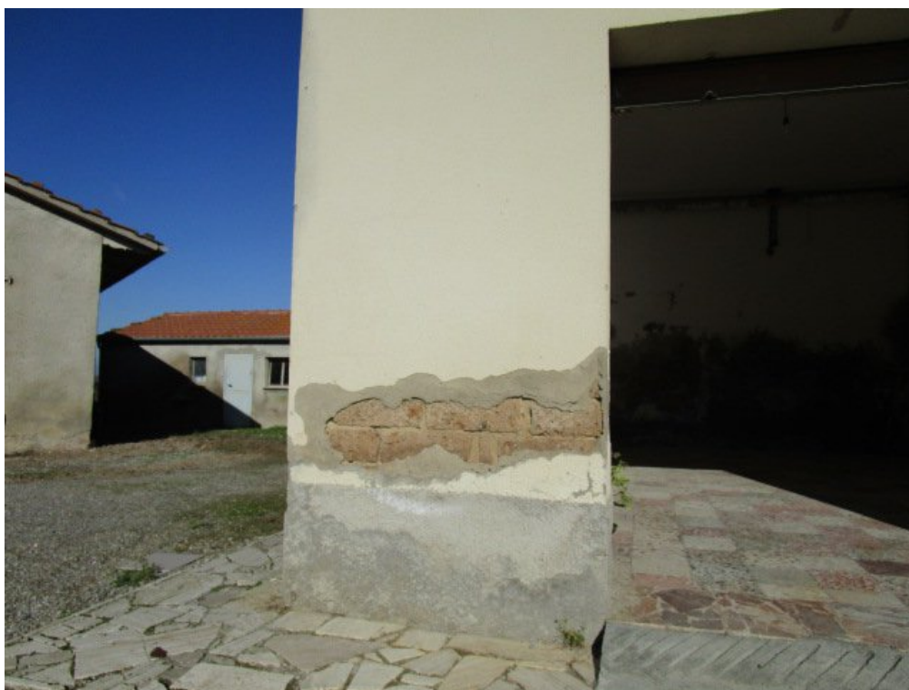
FOTO 11 - particolare muratura ampliamento del 1968 realizzata in blocchi di tufo
