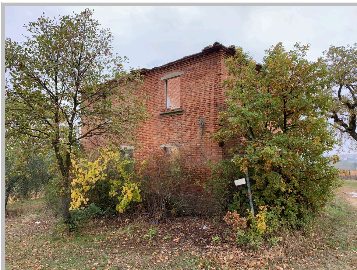
Foto 3 – Fabbricato in oggetto
