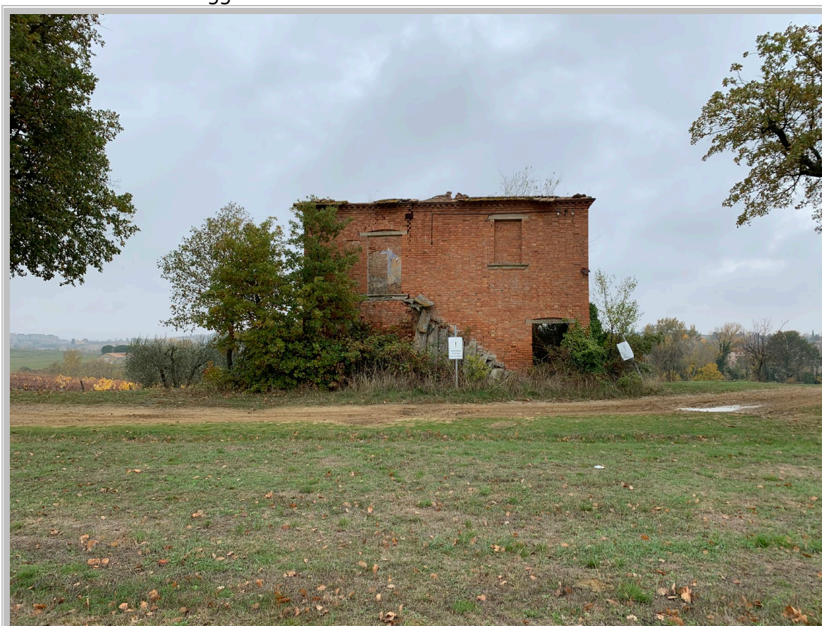
Foto 2 – Fabbricato in oggetto
