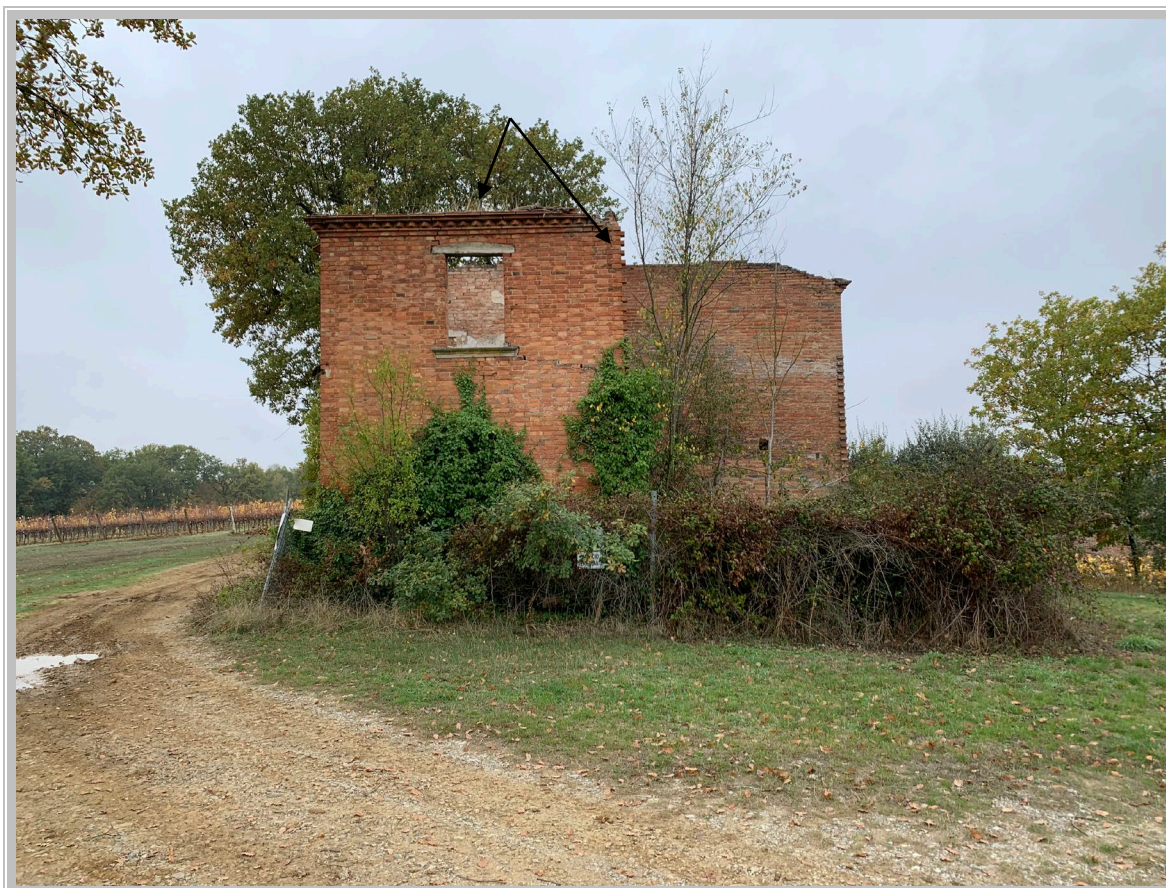
Foto 1 – Fabbricato in oggetto
