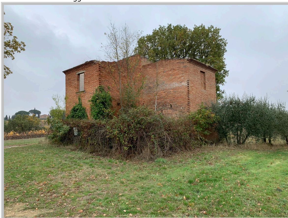
Foto 4 – Fabbricato in oggetto
