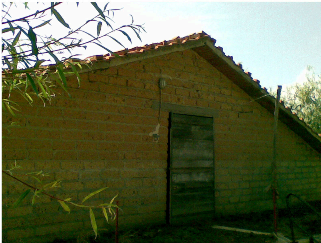
Foto 3 - Lato Sud Ovest - Immagini stato originario annesso
