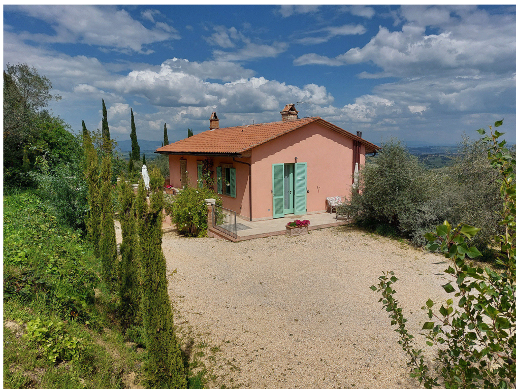
Foto 6 - Lato Nord Ovest e Sud Ovest- STATO ATTUALE
