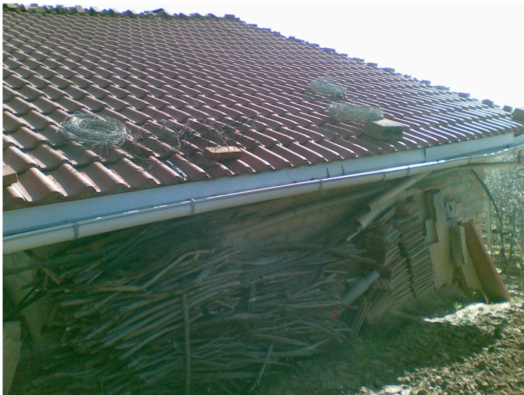
Foto 4 - lato Nord Ovest - Immagini stato originario annesso
