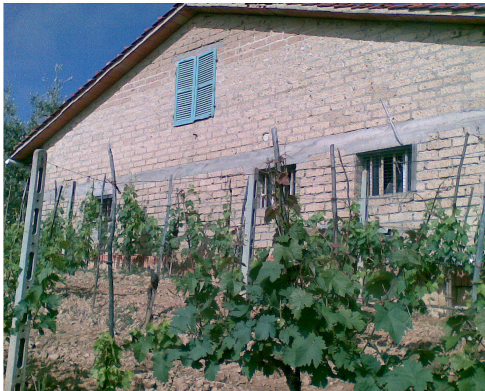
Foto 1 - lato Sud Est - Immagini stato originario annesso
