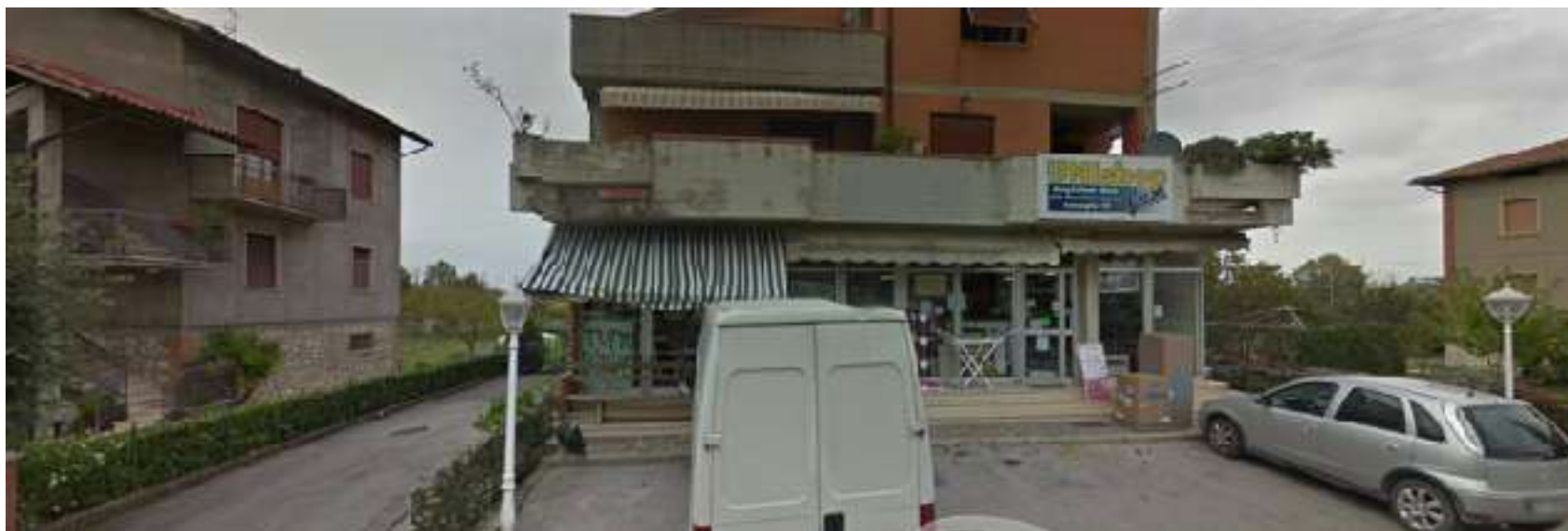
l'area di intervento, fonte google street view
