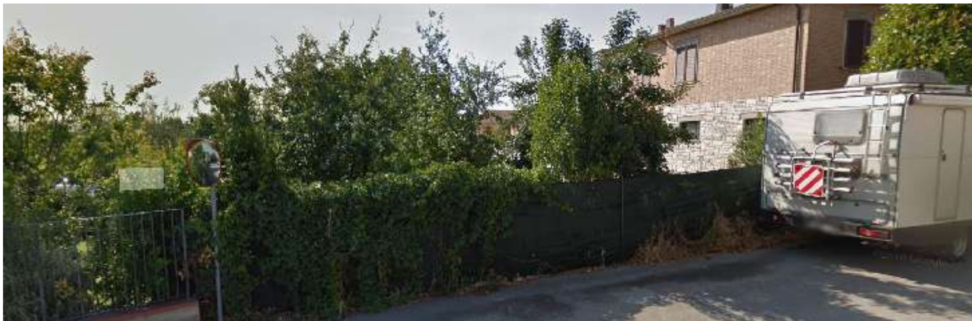
l'area di intervento, fonte google street view
