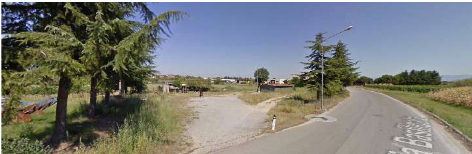
l'area di intervento, fonte google street view
