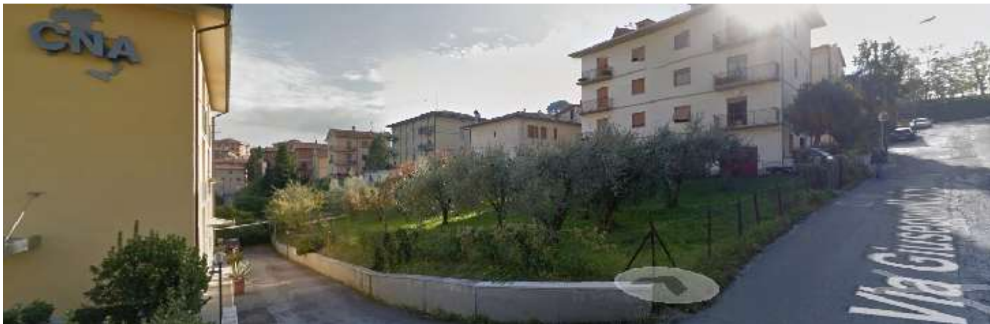
l'area di intervento, fonte google street view
