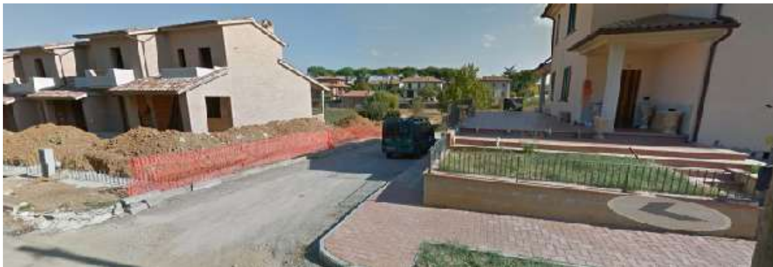
l'area di intervento, fonte google street view
