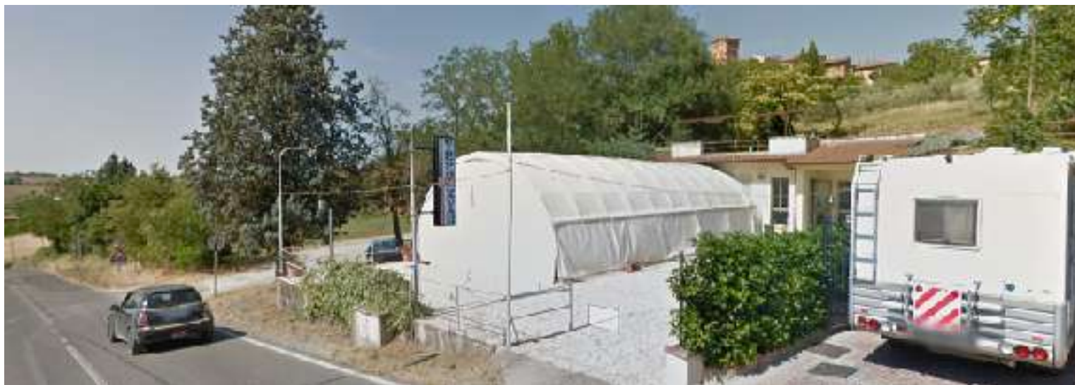
l'area di intervento, fonte google street view
