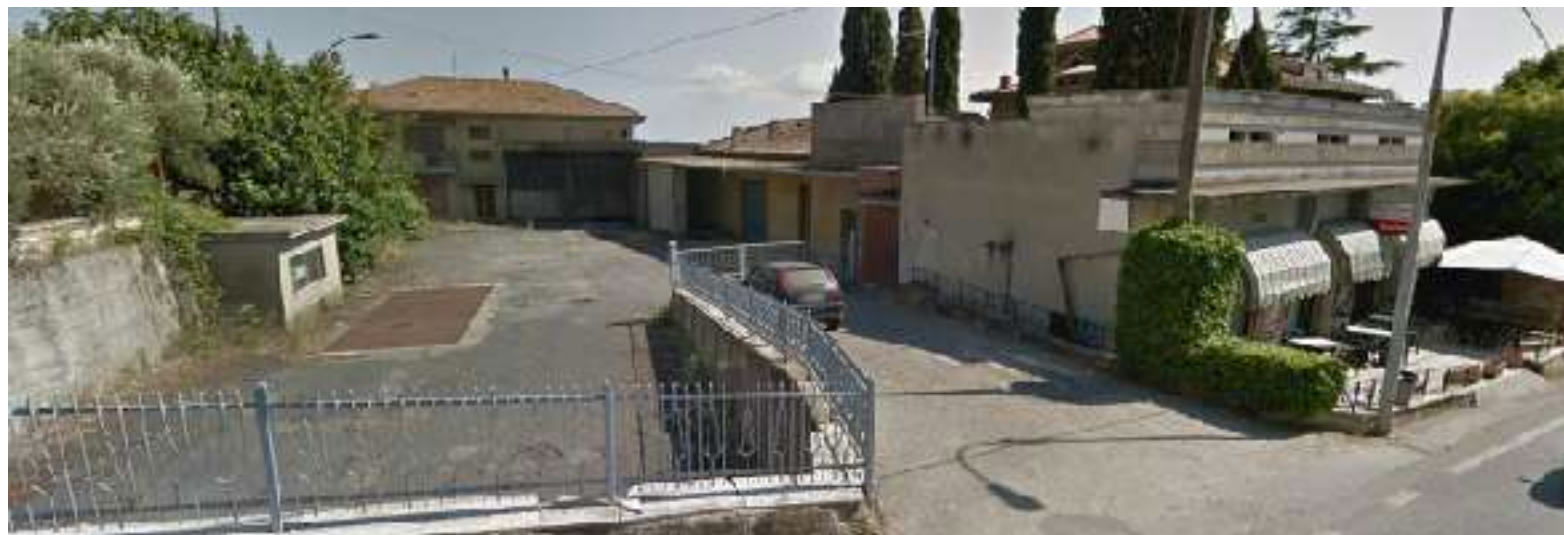
l'area di intervento, fonte google street view
