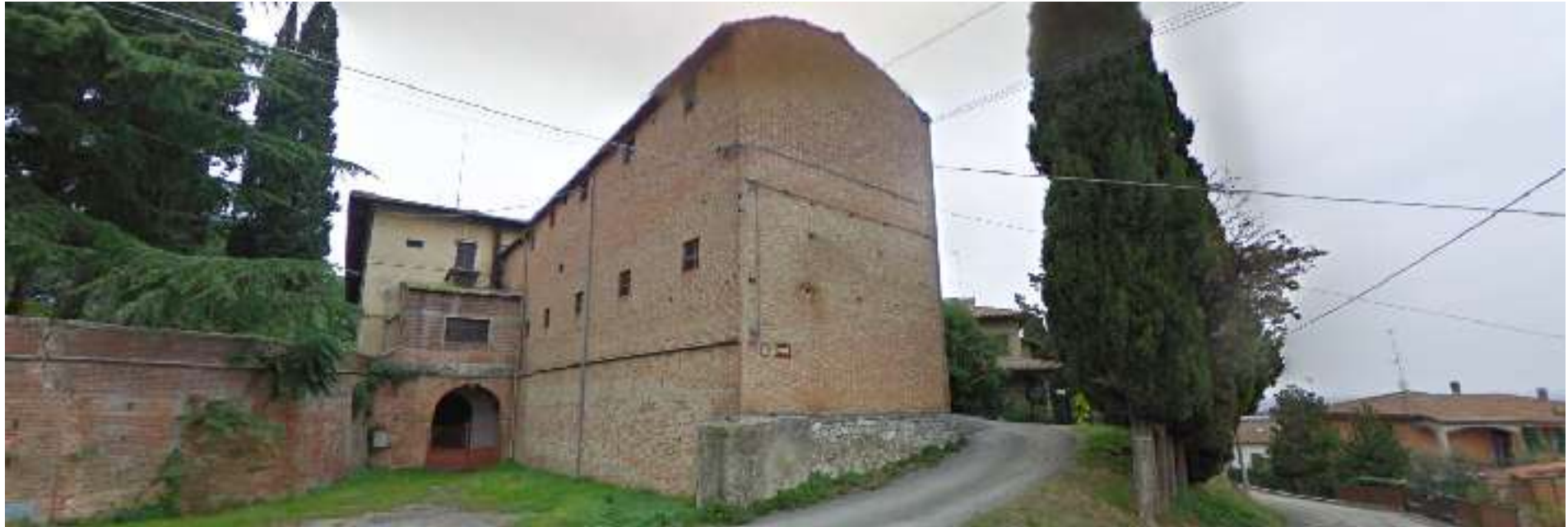
l'area di intervento, fonte google street view
