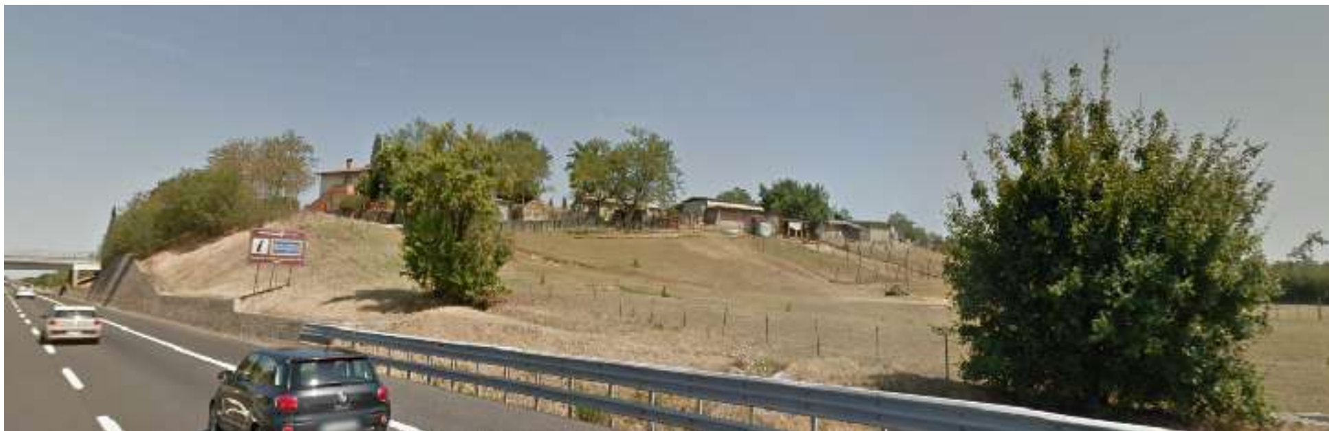
l'area di intervento, fonte google street view
