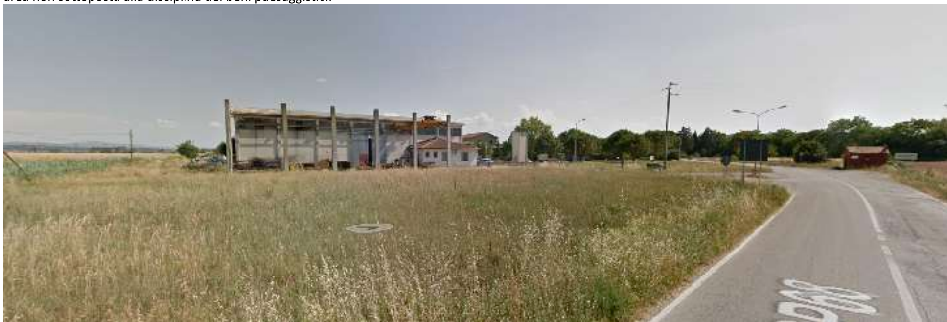
L'area di intervento, fonte google street view
