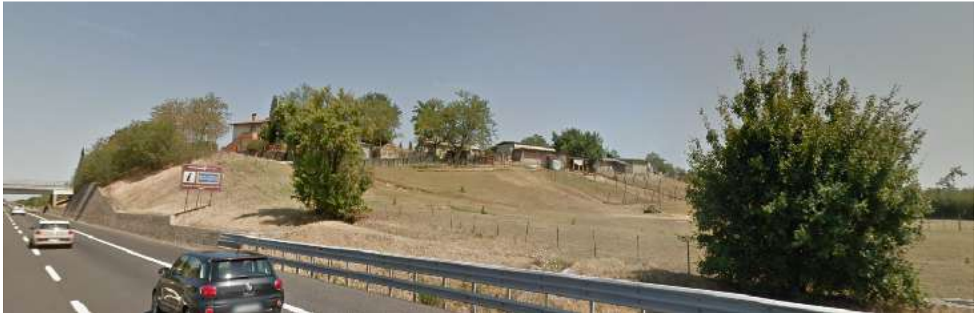
l'area di intervento, fonte google street view
