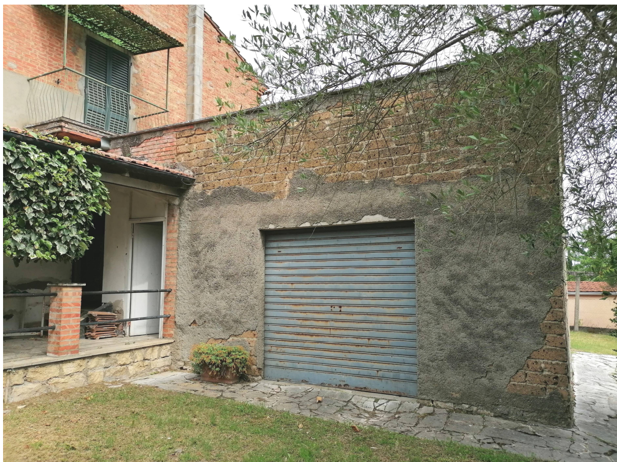
FOTO 4 Prospetto Ovest, parziale su corte esclusiva
