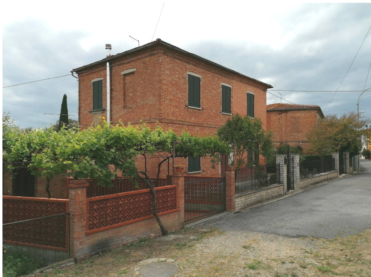
FOTO 6 Prospetto su Via Lombardia e Prospetto Est
