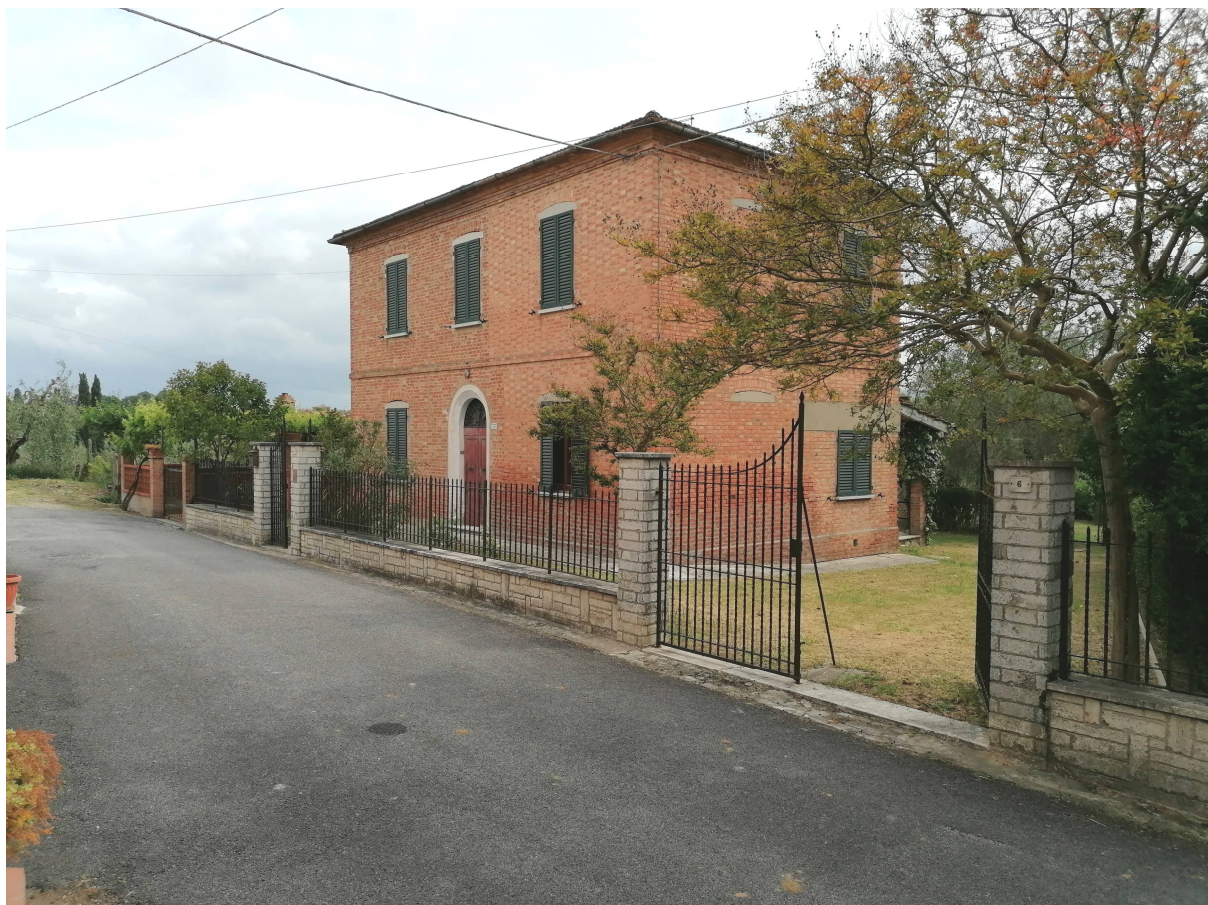
FOTO 2 Prospetto su Via Lombardia e Prospetto Ovest
