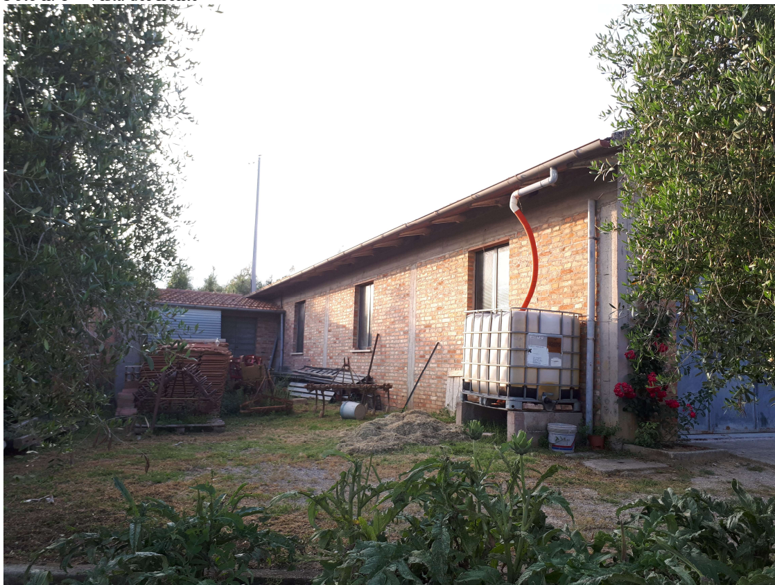
Foto n. 2 – Vista del lato sinistro
