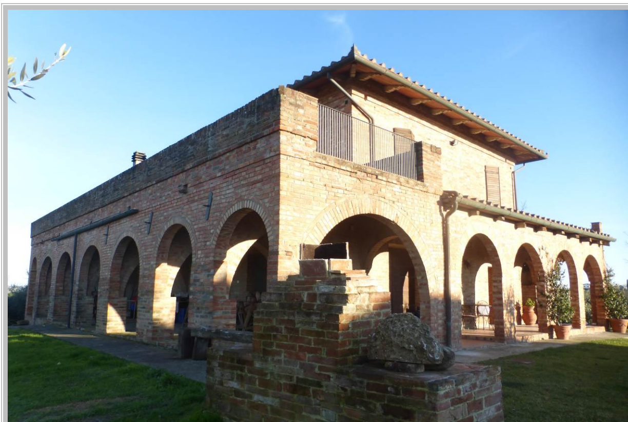
Foto 5 – Fabbricato in oggetto
