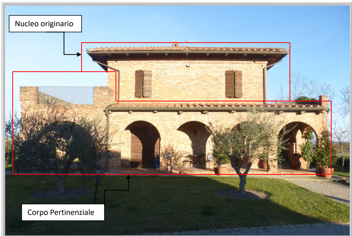
Foto 2 – Fabbricato in oggetto
