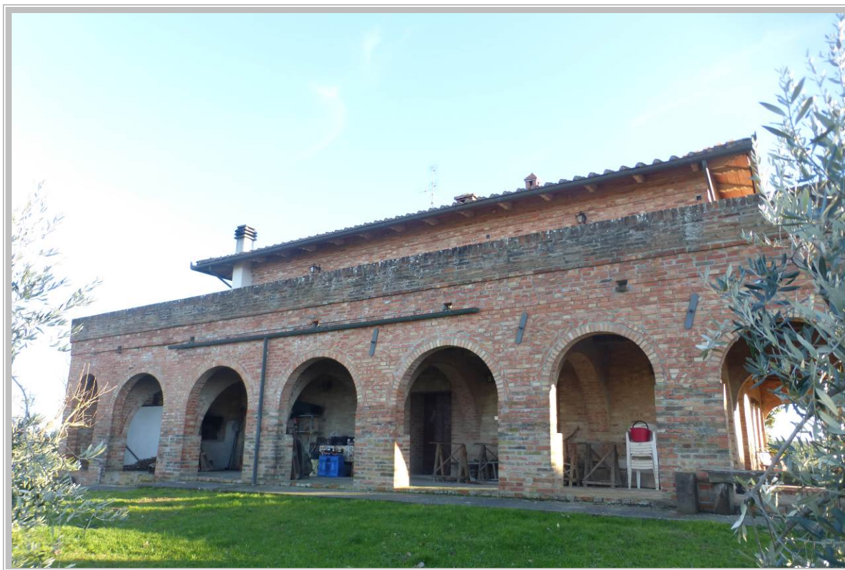
Foto 3 – Fabbricato in oggetto
