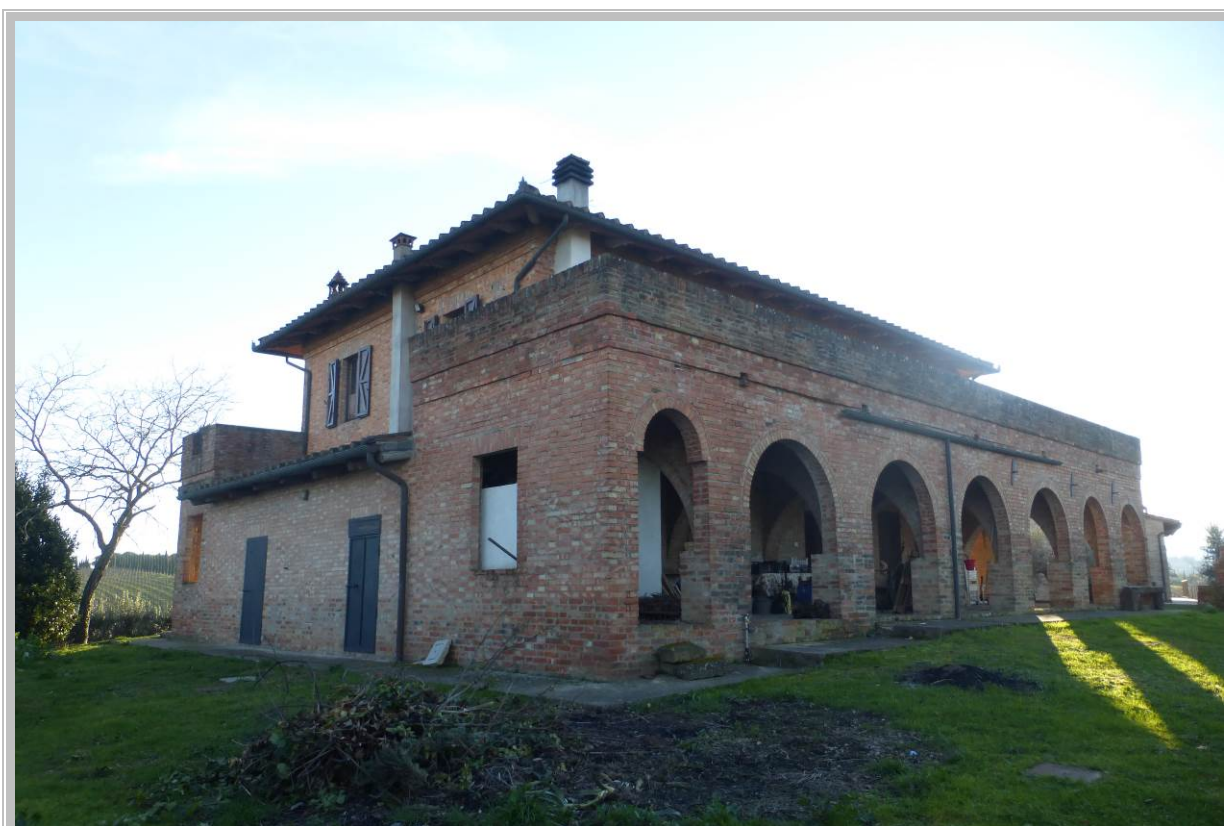
Foto 6 – Fabbricato in oggetto
