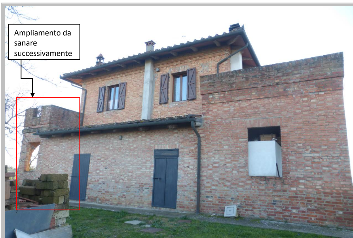
Foto 4 – Fabbricato in oggetto
