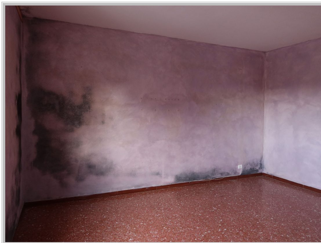
Foto 5 – Interno del Fabbricato principale – Piano Primo
