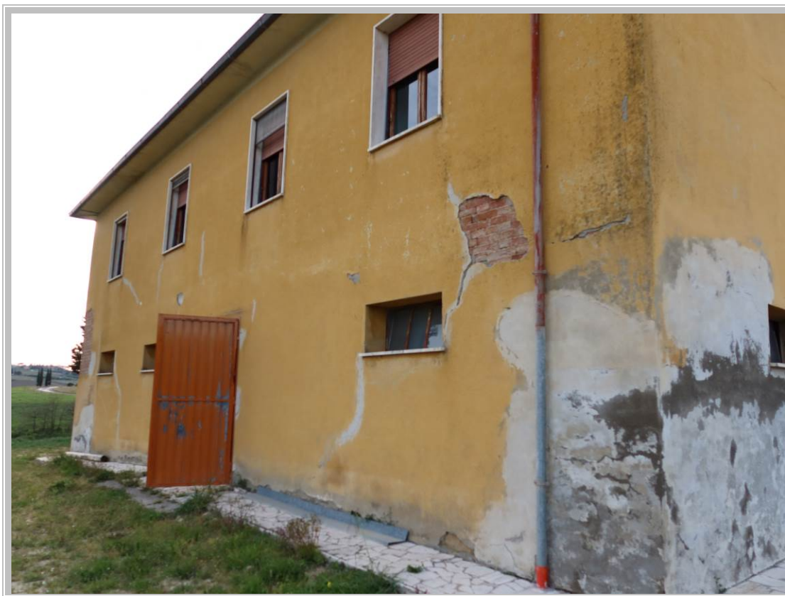
Foto 3 – Fabbricato in oggetto (Edificio principale)
