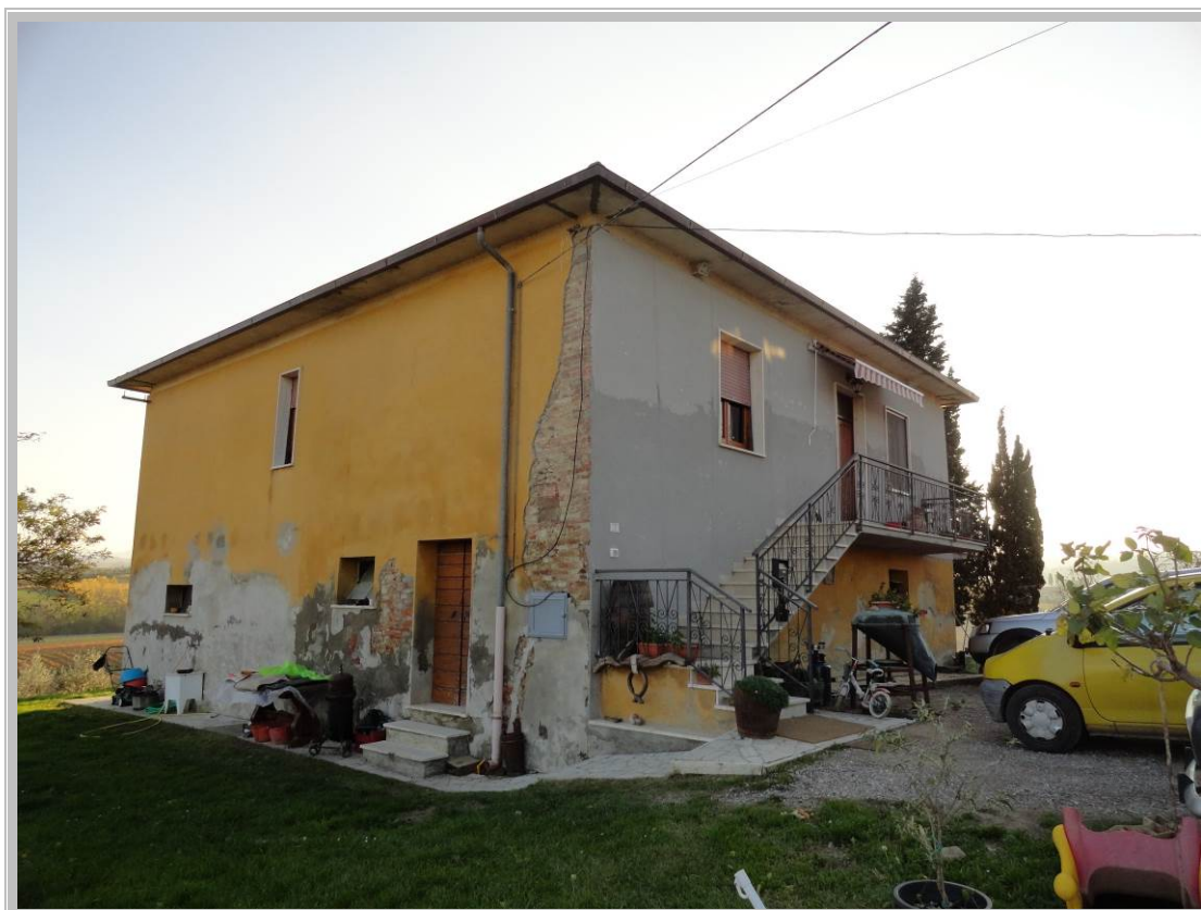
Foto 2 – Fabbricato in oggetto (Edificio principale)
