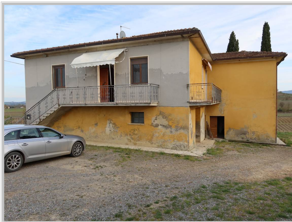
Foto 1 – Fabbricato in oggetto (Edificio principale)
