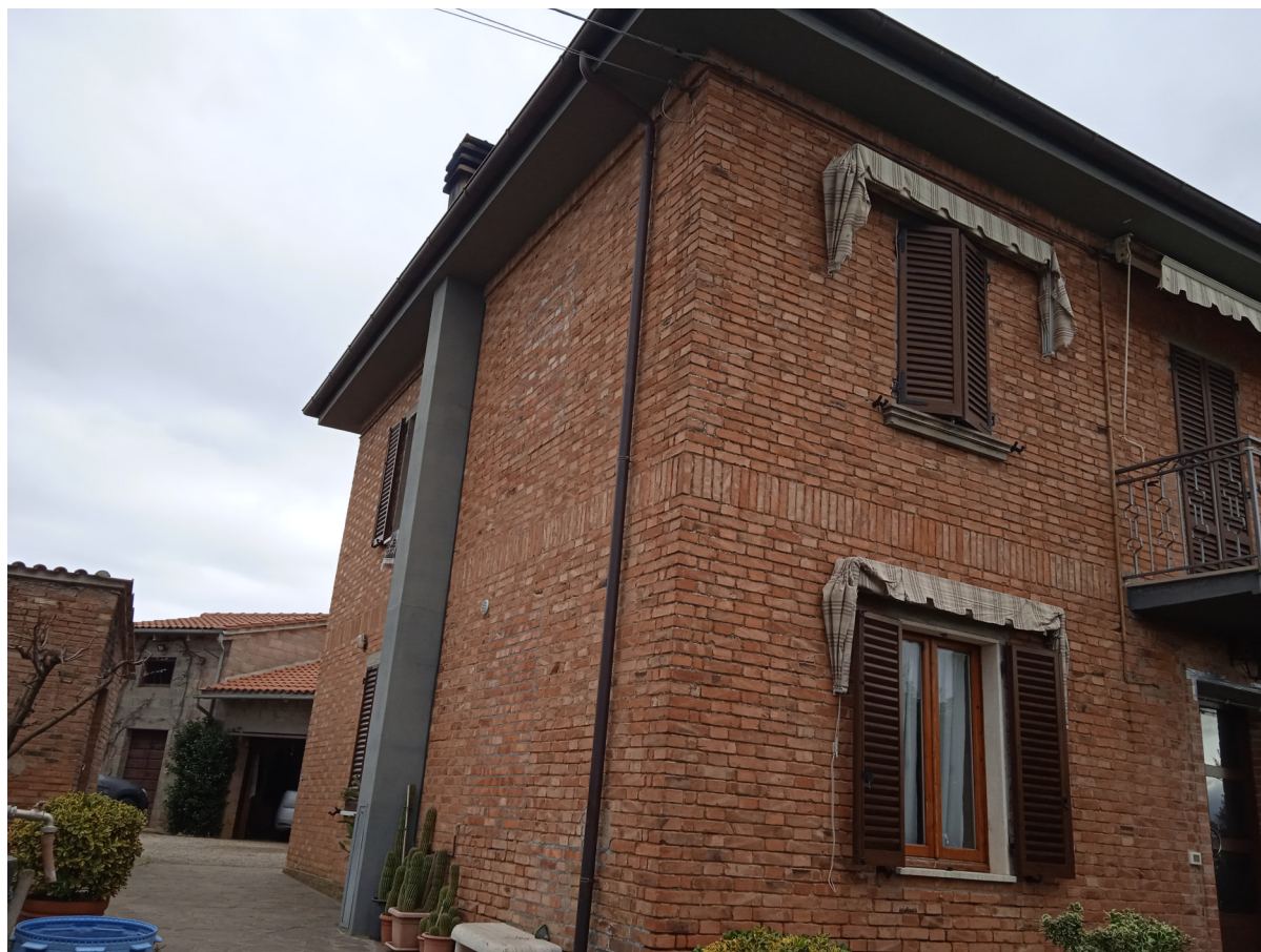
Foto n. 2 – Vista del lato sinistro
