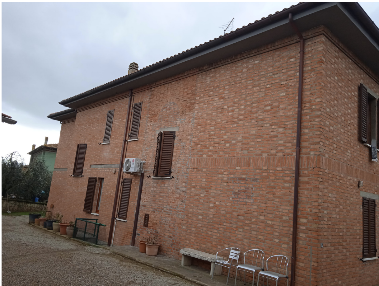
Foto n. 4 – Vista del lato destro
