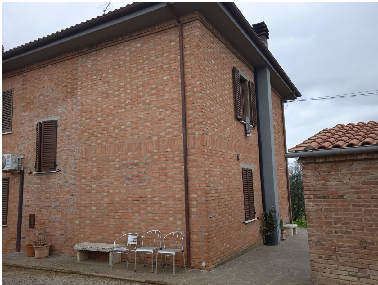
Foto n. 3 – Vista del retro
