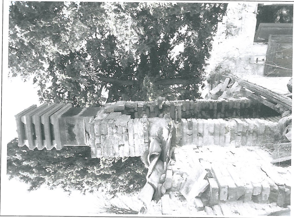
FOTO – COLLEGAMENTO CROLLATO TRA EDIFICIO PRINCIPALE E PERTINENZA N.3
