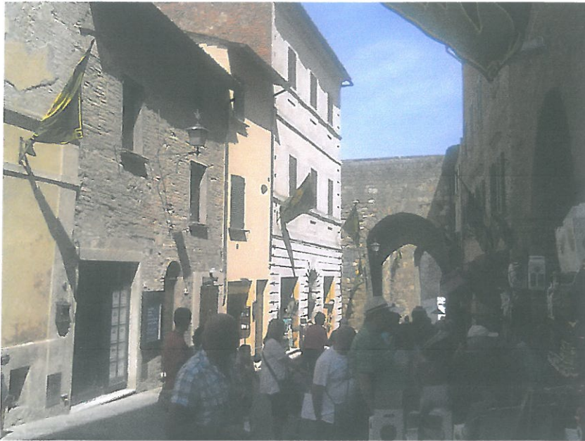
FOTO 2 – Veduta del fabbricato da Via di Gracciano nel Corso.-
