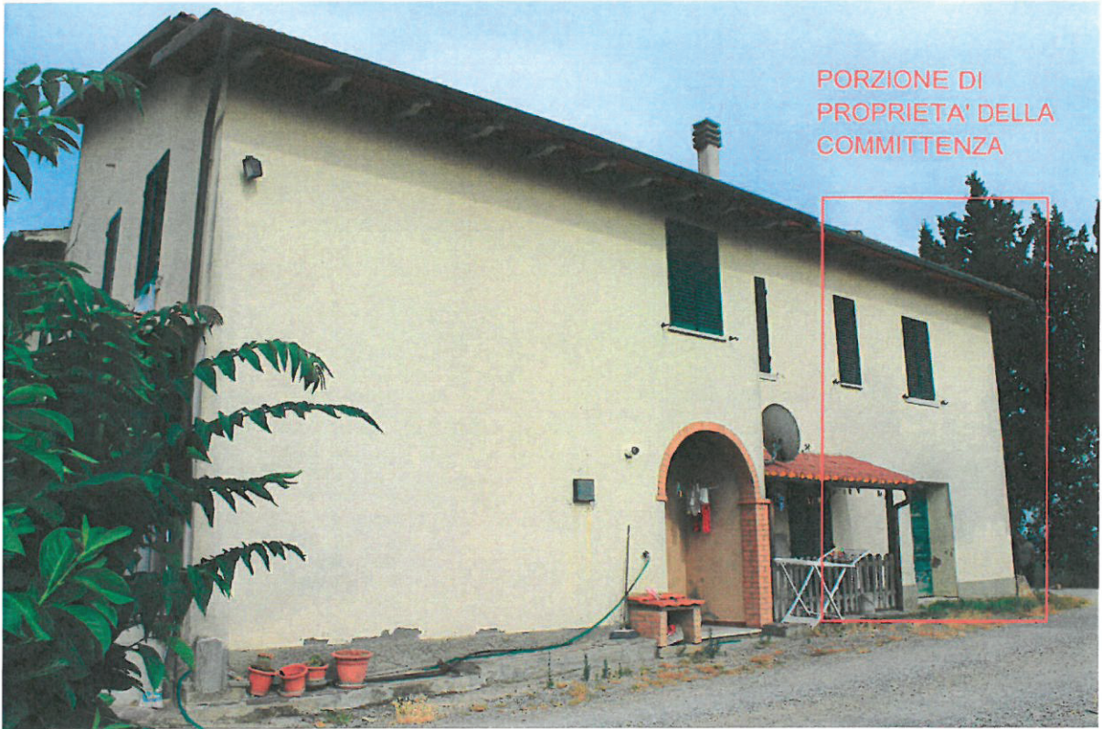
FOTO 1 - FABBRICATO (P.LLA 40) - PROSPETTO OVEST
