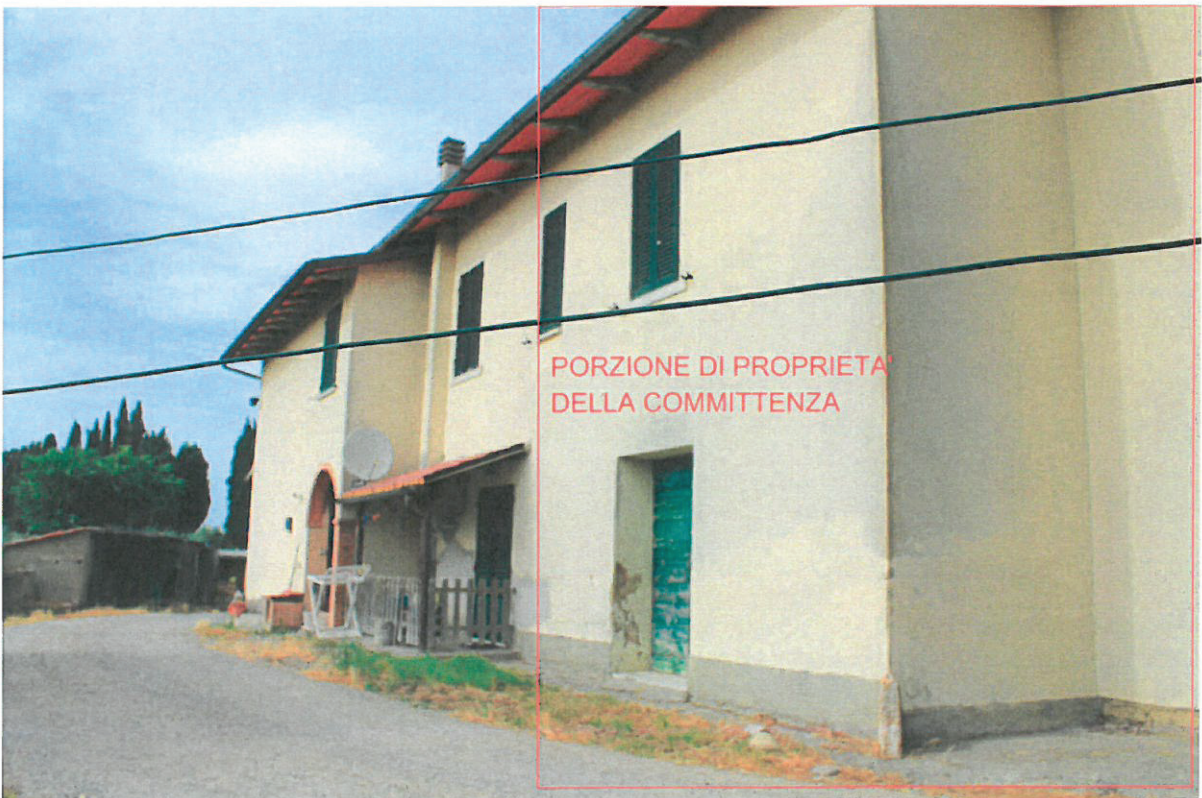
FOTO 2 - FABBRICATO (P.LLA 40) - PROSPETTO OVEST
