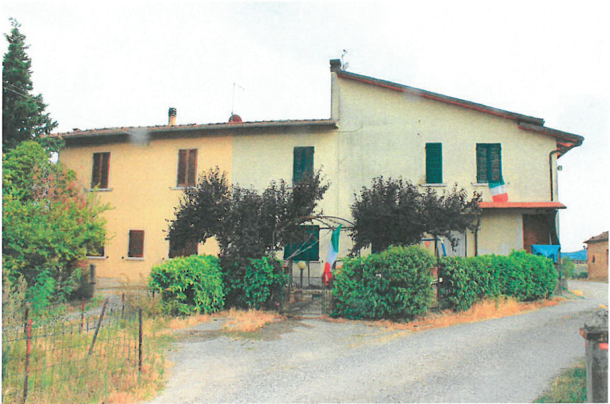
FOTO 10 - FABBRICATO (P.LLA 40) - PROSPETTO NORD
