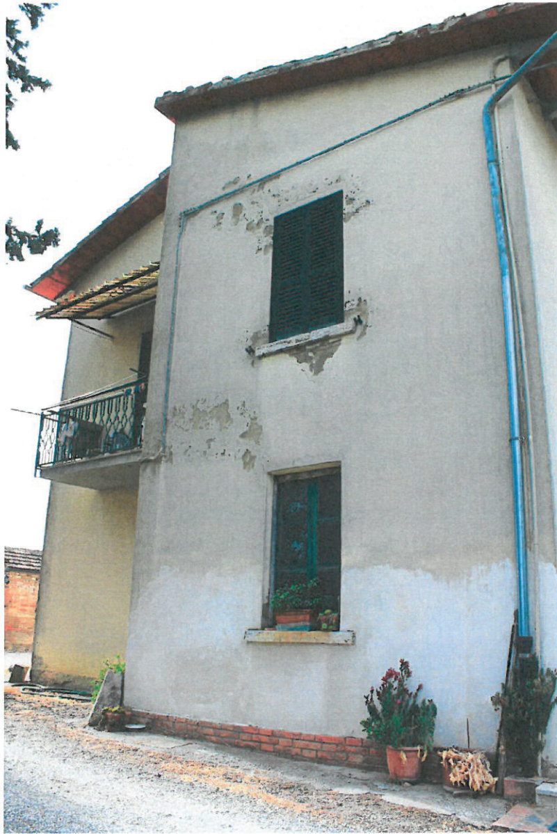
FOTO 4 - FABBRICATO (P.LLA 40) - PROSPETTO SUD
