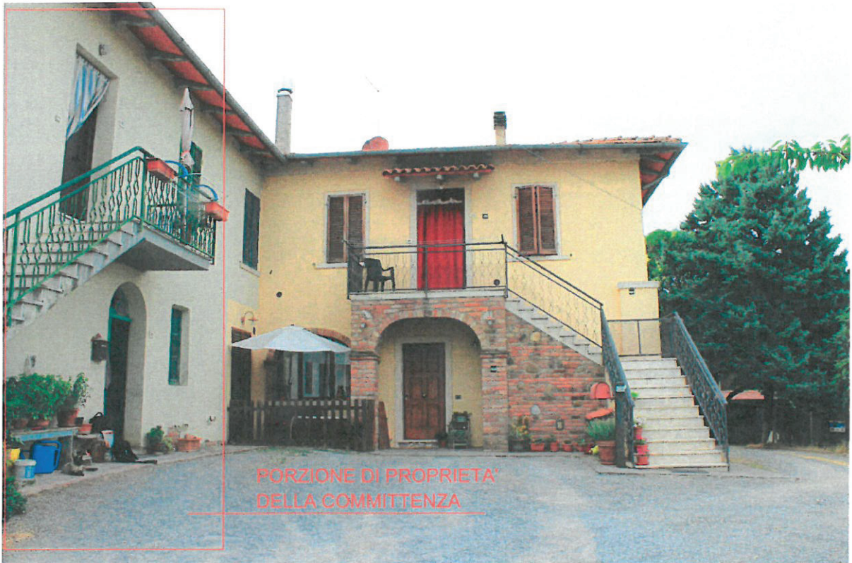
FOTO 7 - FABBRICATO (P.LLA 40) - PROSPETTO SUD/EST
