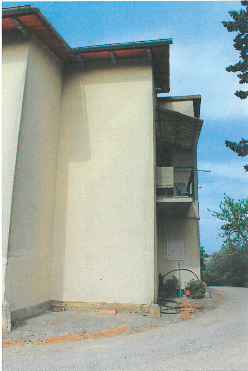
FOTO 3 - FABBRICATO (P.LLA 40) - PROSPETTO SUD/OVEST
