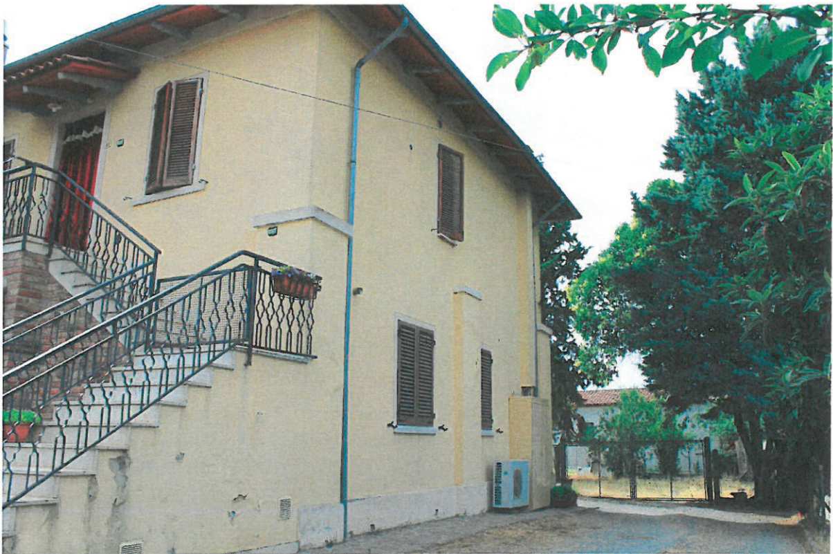
FOTO 8 - FABBRICATO (P.LLA 40) - PROSPETTO SUD/EST
