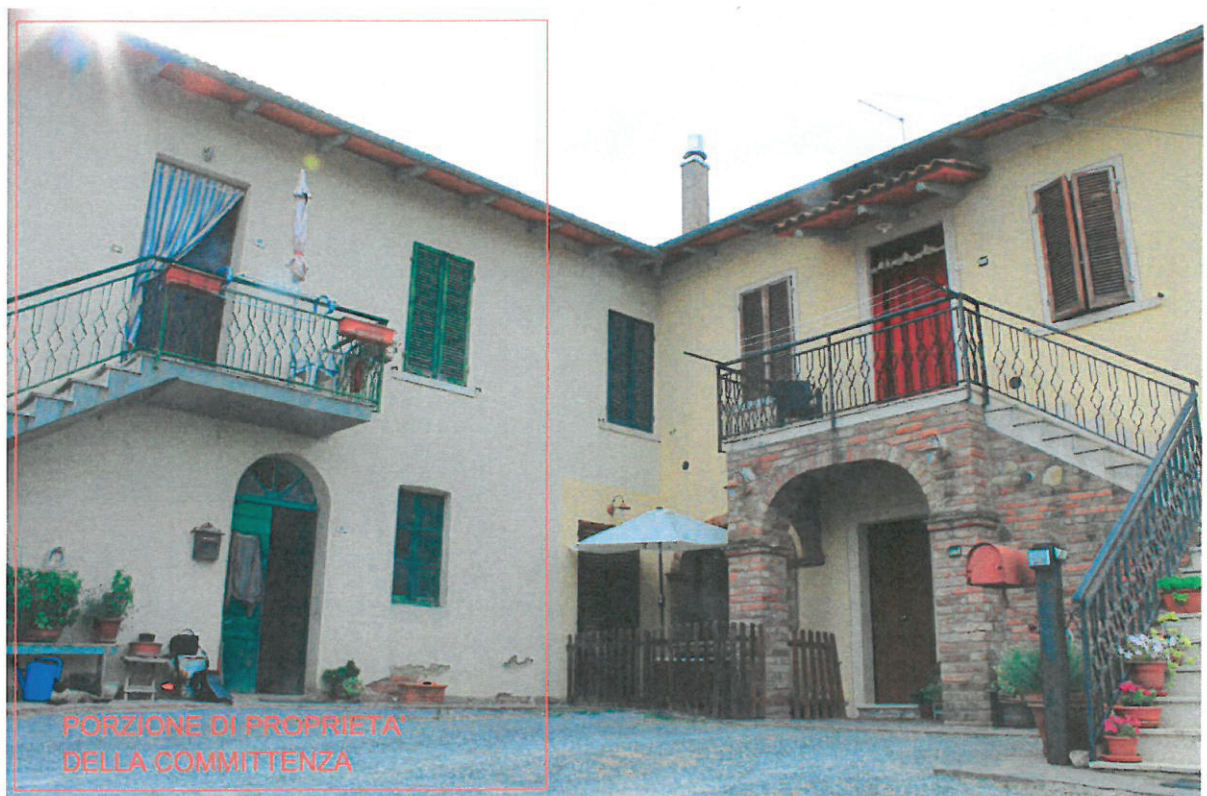
FOTO 6 - FABBRICATO (P.LLA 40) - PROSPETTO SUD/EST
