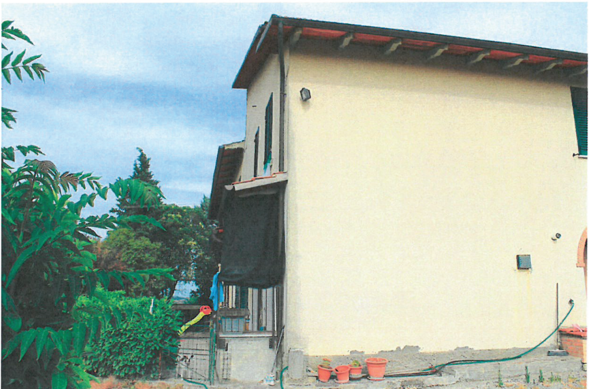
FOTO 11 - FABBRICATO (P.LLA 40) - PROSPETTO NORD/OVEST
