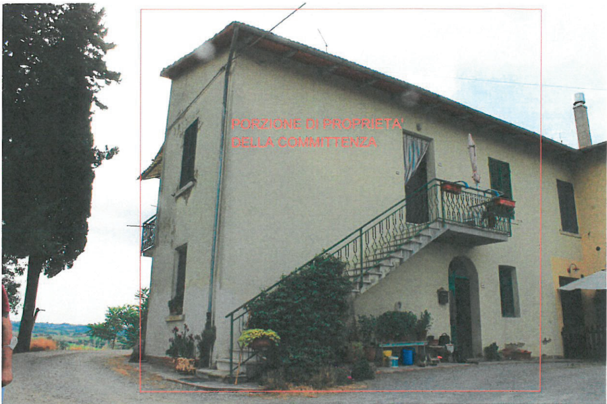
FOTO 5 - FABBRICATO (P.LLA 40) - PROSPETTO SUD/EST
