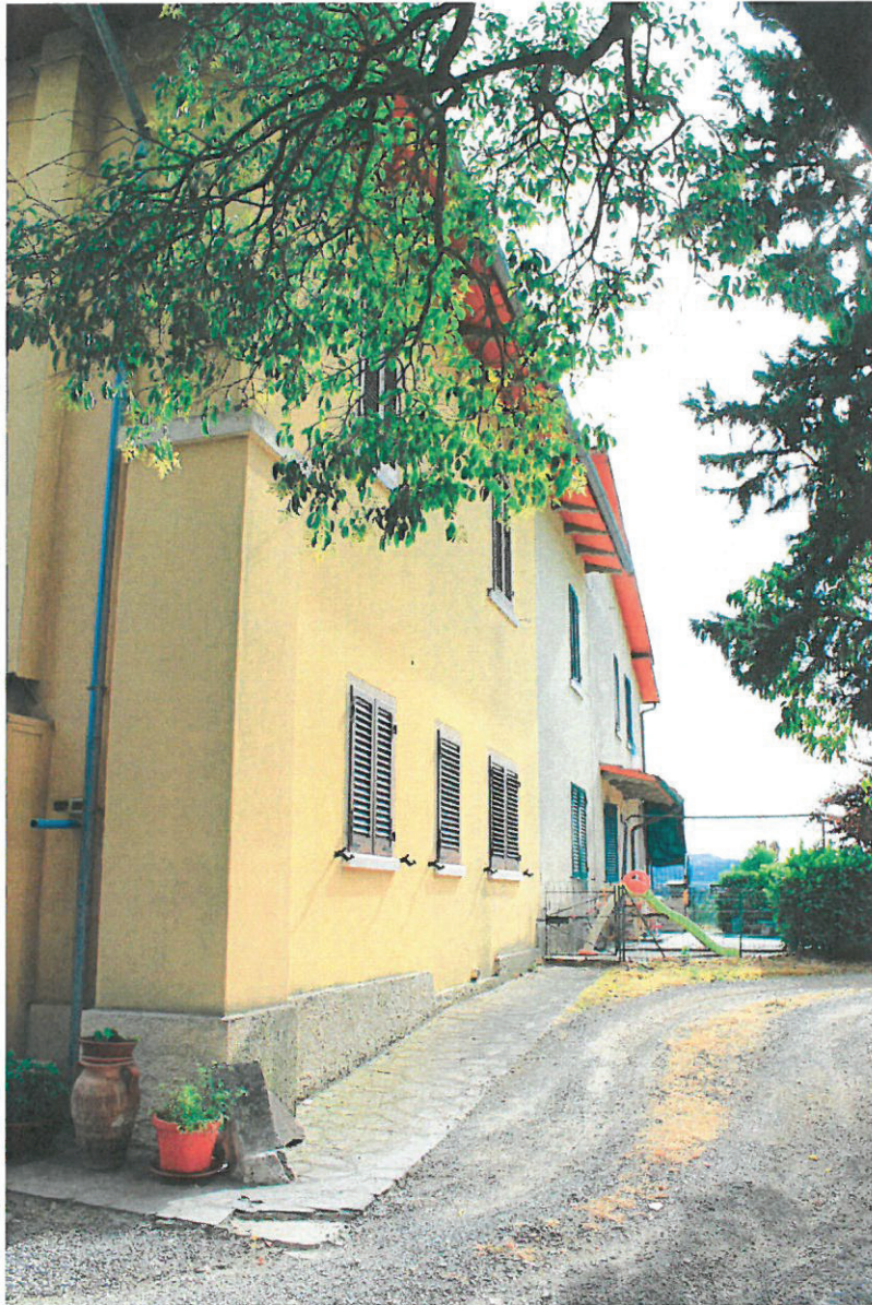
FOTO 9 - FABBRICATO (P.LLA 40) - PROSPETTO NORD
