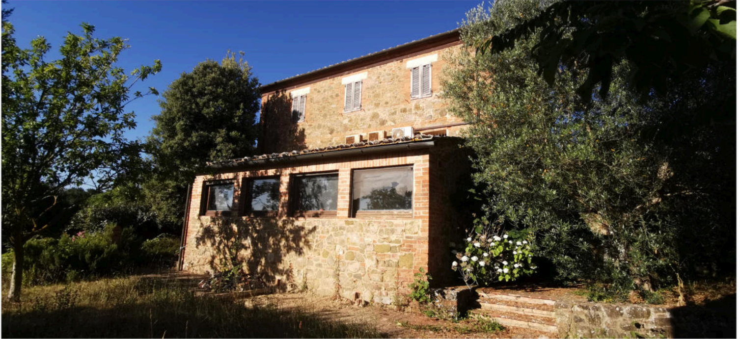
Foto 7- Prospetto EST vista fabbricato principale e secondo corpo minore
