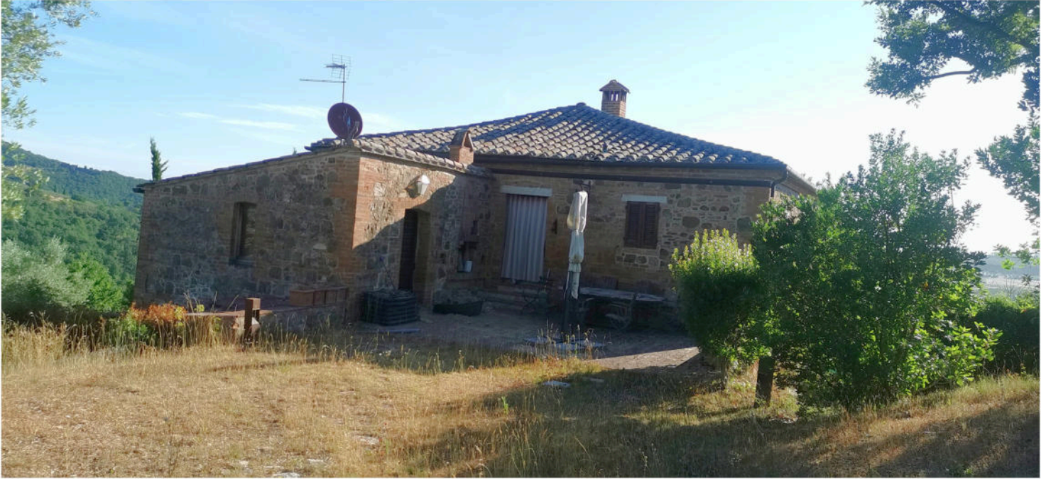
Foto 1 - Prospetto OVEST ingresso a fabbricato principale e corpo minore 1
