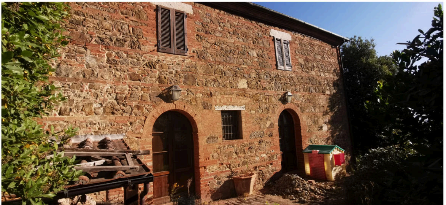
Foto 6 - Prospetto SUD fabbricato principale
