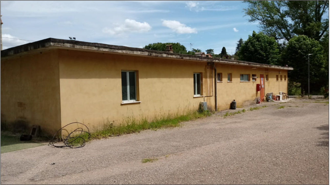
Foto n. 5 - facciata esterna lato ovest del fabbricato
