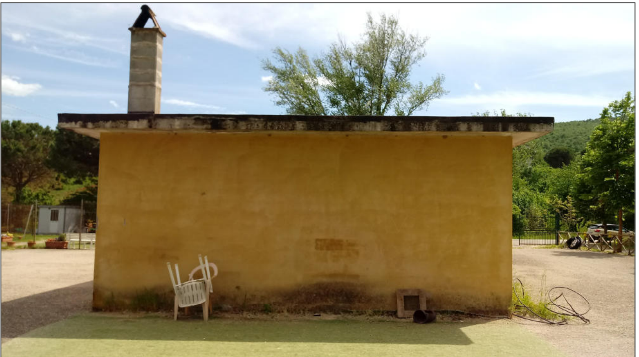
Foto n. 6 - facciata esterna lato nord del fabbricato (porzione)
