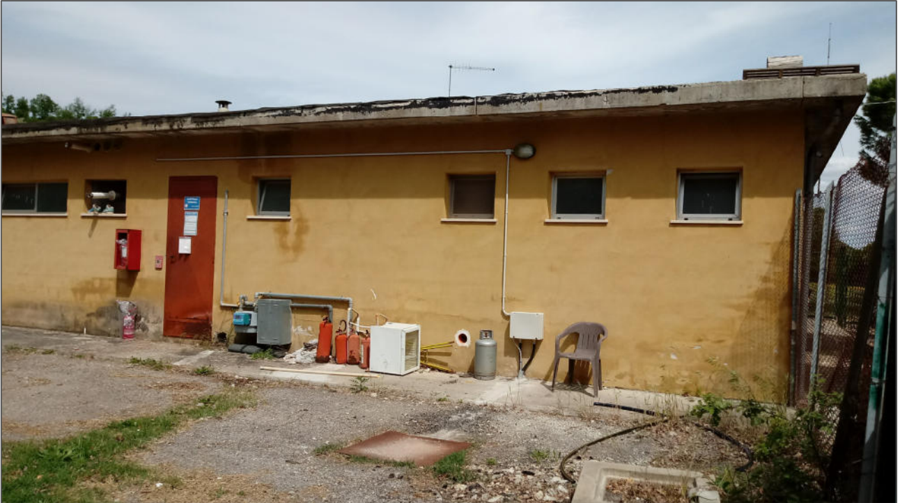
Foto n. 3 - facciata esterna lato ovest del fabbricato
