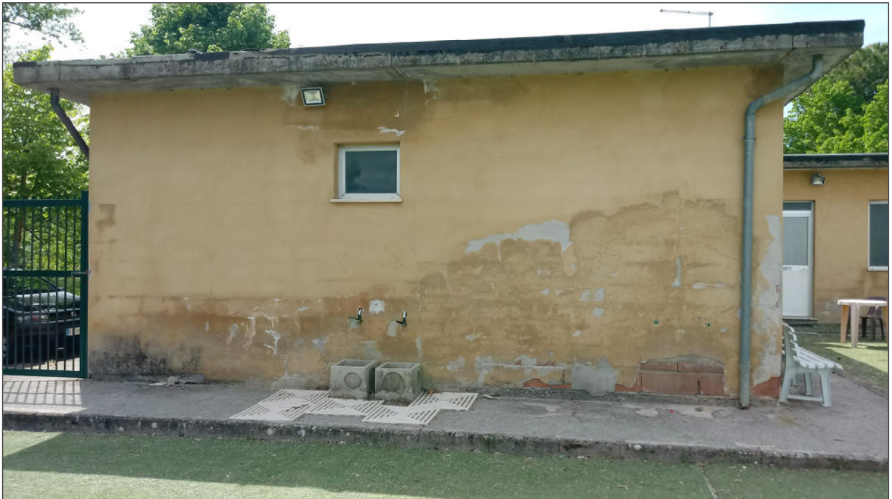
Foto n. 9 - facciata esterna lato est del fabbricato (porzione)
