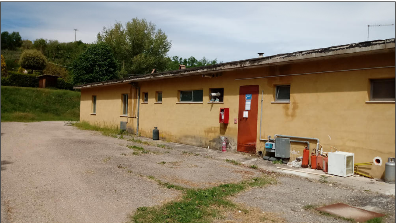
Foto n. 4 - facciata esterna lato ovest del fabbricato
