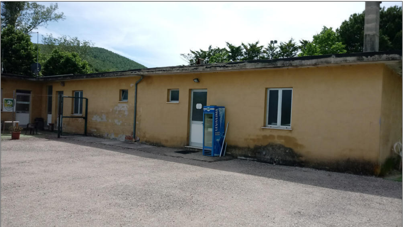
Foto n. 7 - facciata esterna lato est del fabbricato (porzione)
