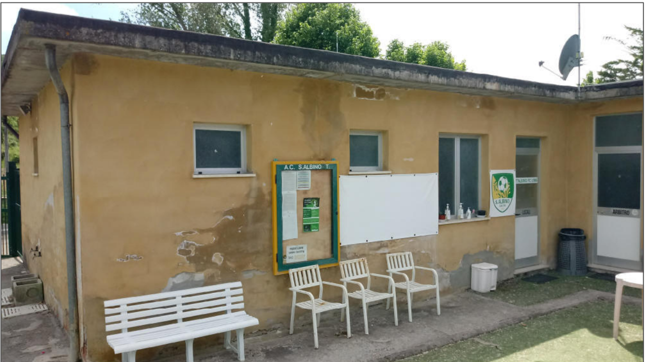
Foto n. 8 - facciata esterna lato nord del fabbricato (porzione)
