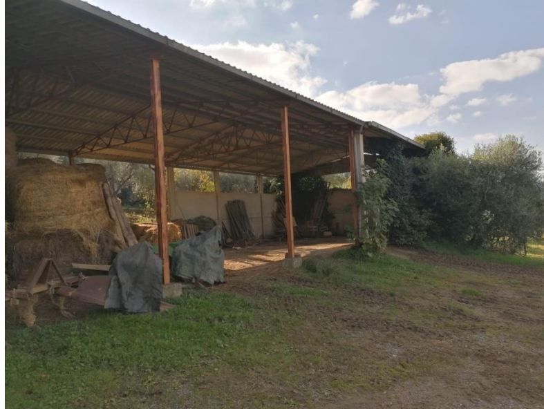
Vista dei fienili esistenti
