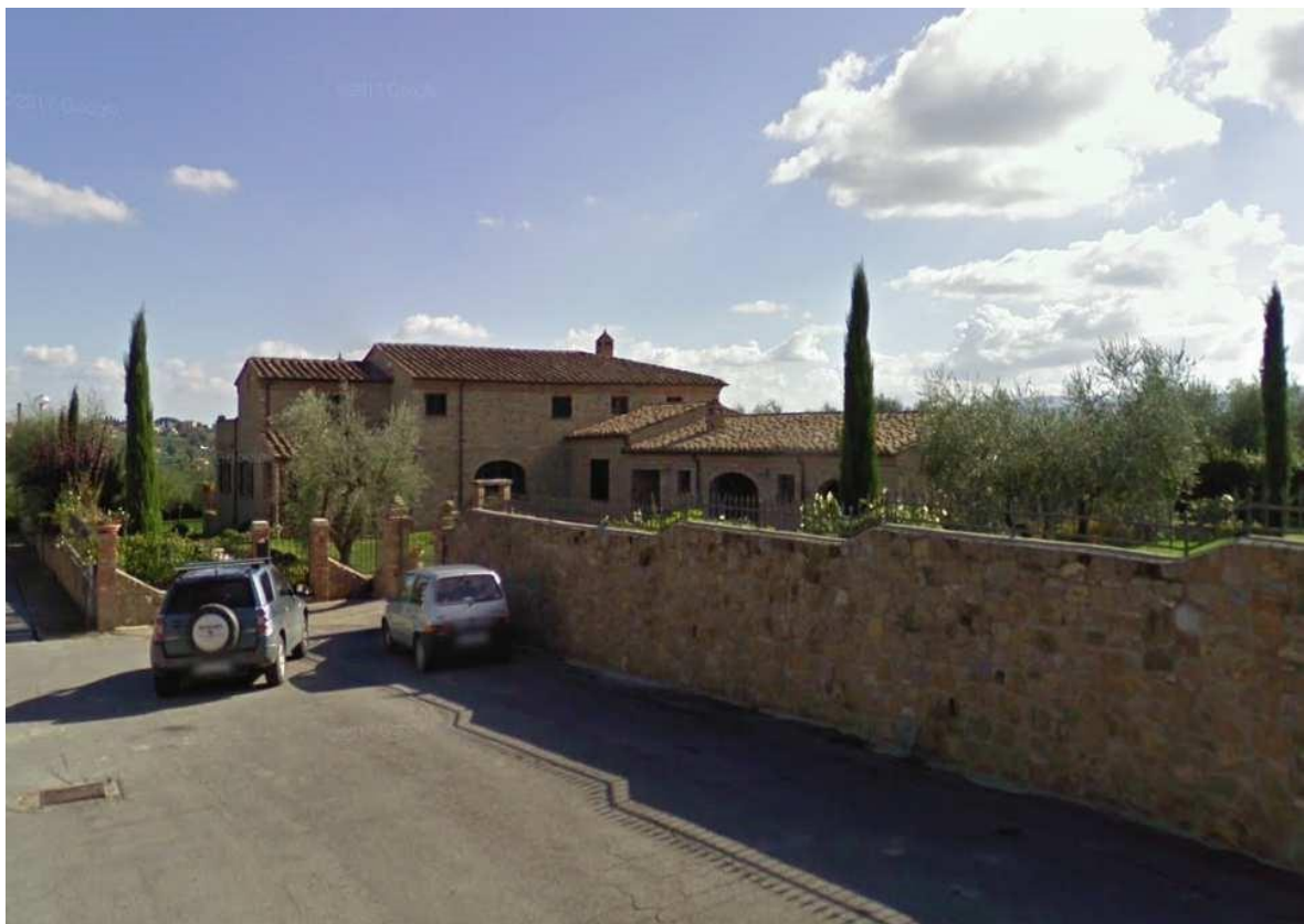
Immagine 8. Intervento di edilizia residenziale in via Marzabotto. Ripresa fotografica effettuata nel Maggio 2018.
