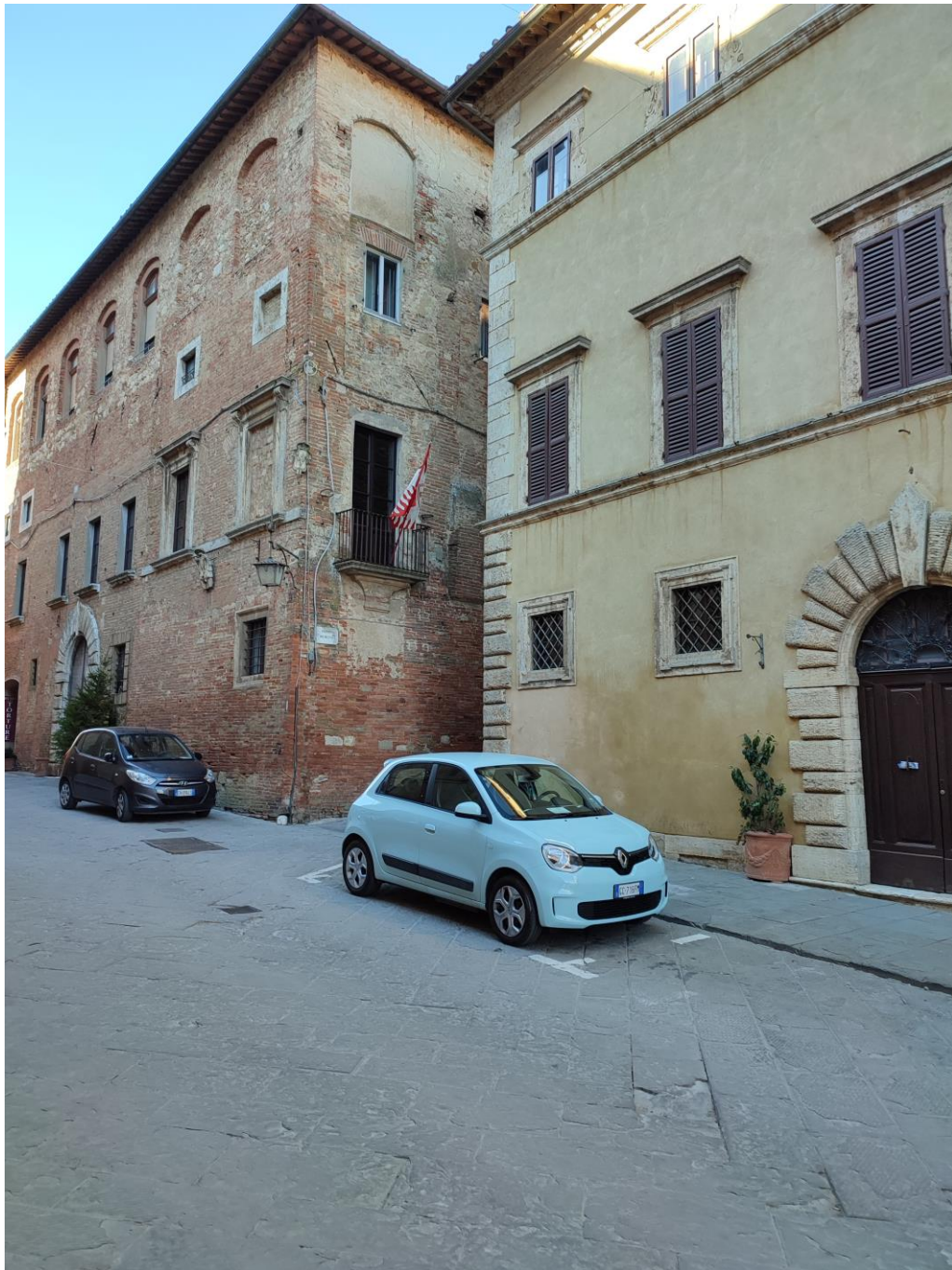
FOTO 1 – Veduta di Vicolo Remoto da Via di San Donato.-
