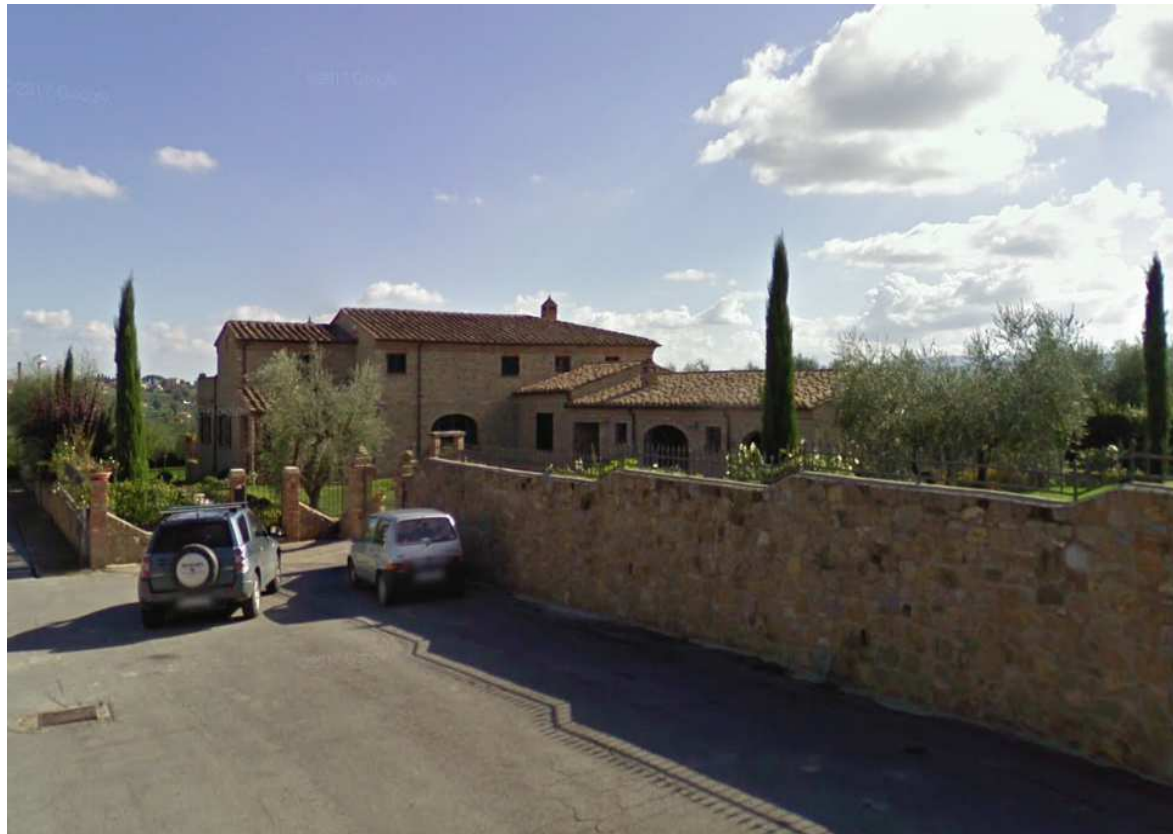
Immagine 7. Intervento di edilizia residenziale in via Marzabotto. Ripresa fotografica effettuata nel Maggio 2018.
