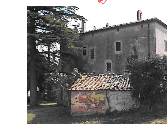
Foto n. 2 - Fronte e lato sinistro della villa
