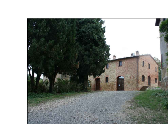
Foto n. 4 - Lato sinistro e retro del podere
