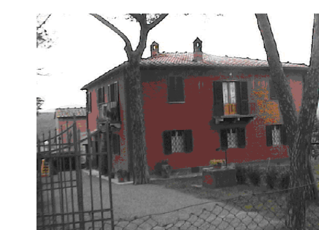
Foto n. 3 - Retro e lato destro
