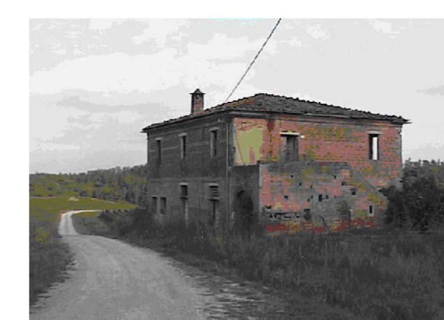
Foto n. 1 - Fronte e lato sinistro
