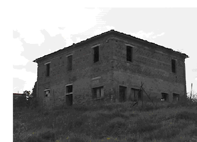
Foto n. 3 - Lato destro e retro
