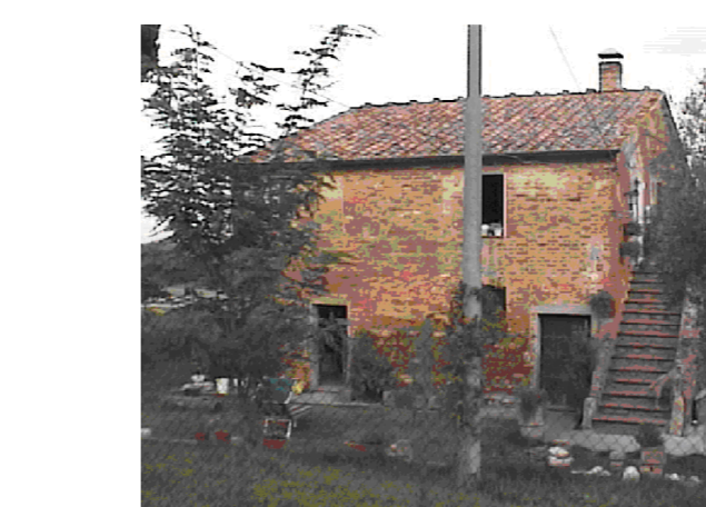
Foto n. 1 - Lato sinistro e fronte
