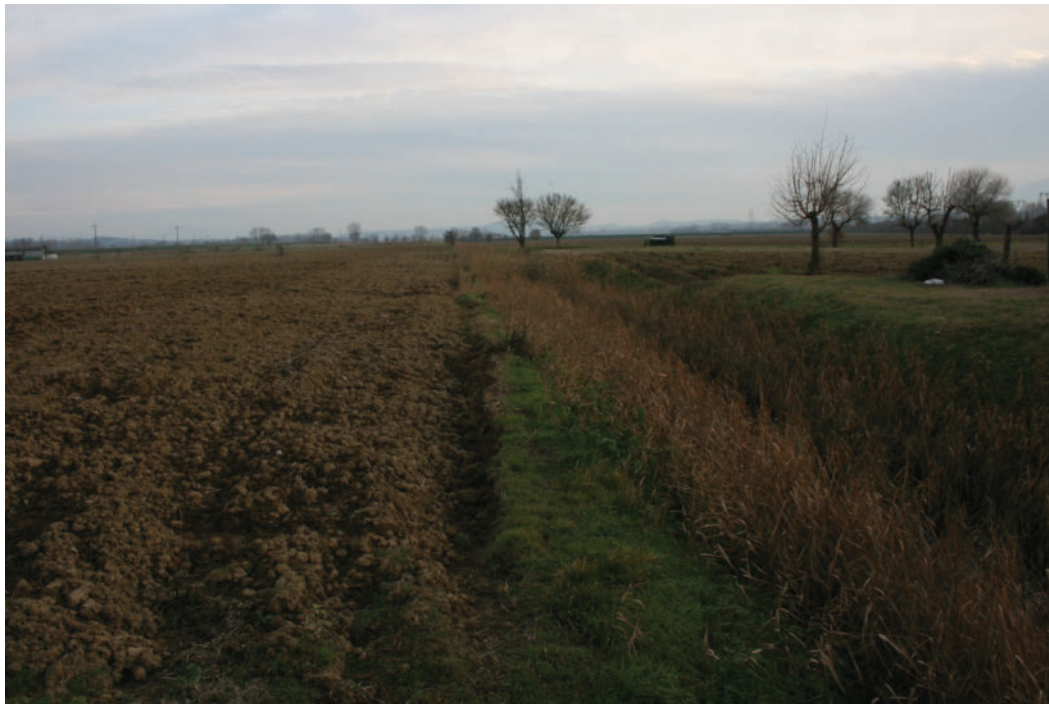
Figura 7.10 - Fotografia 2 , vista verso valle Canale Consorziale Fontanino
