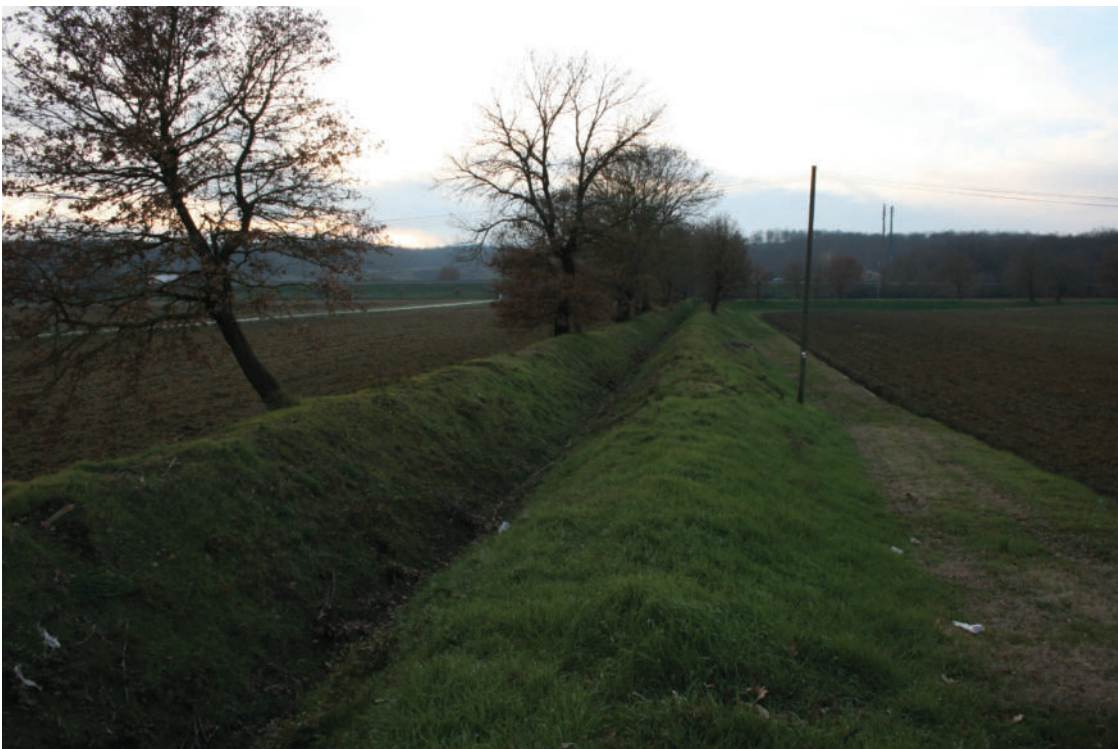
Figura 7.14 - Fotografia 5, vista verso monte affluente Val di Seste
