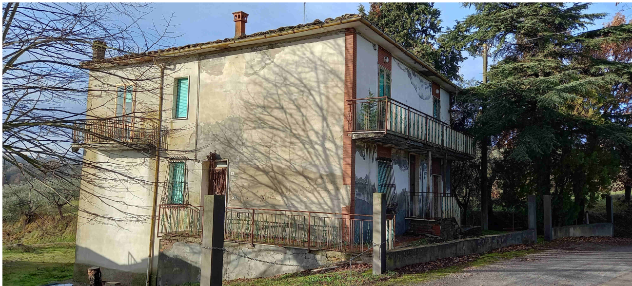
Foto n. 1 – Vista del fronte
