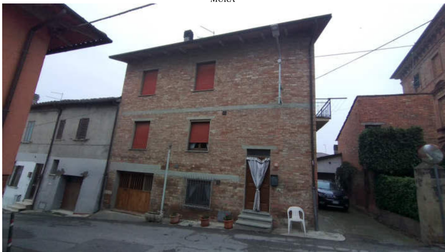
Foto n°01- PROSPETTO SU VIA DELLE VECCHIE MURA
