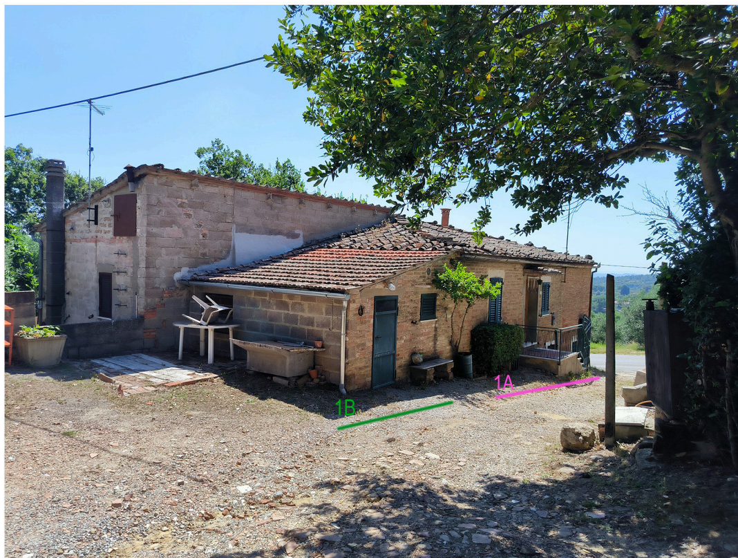
Foto 1 - Abitazione rurale prospetto Nord e Ovest
