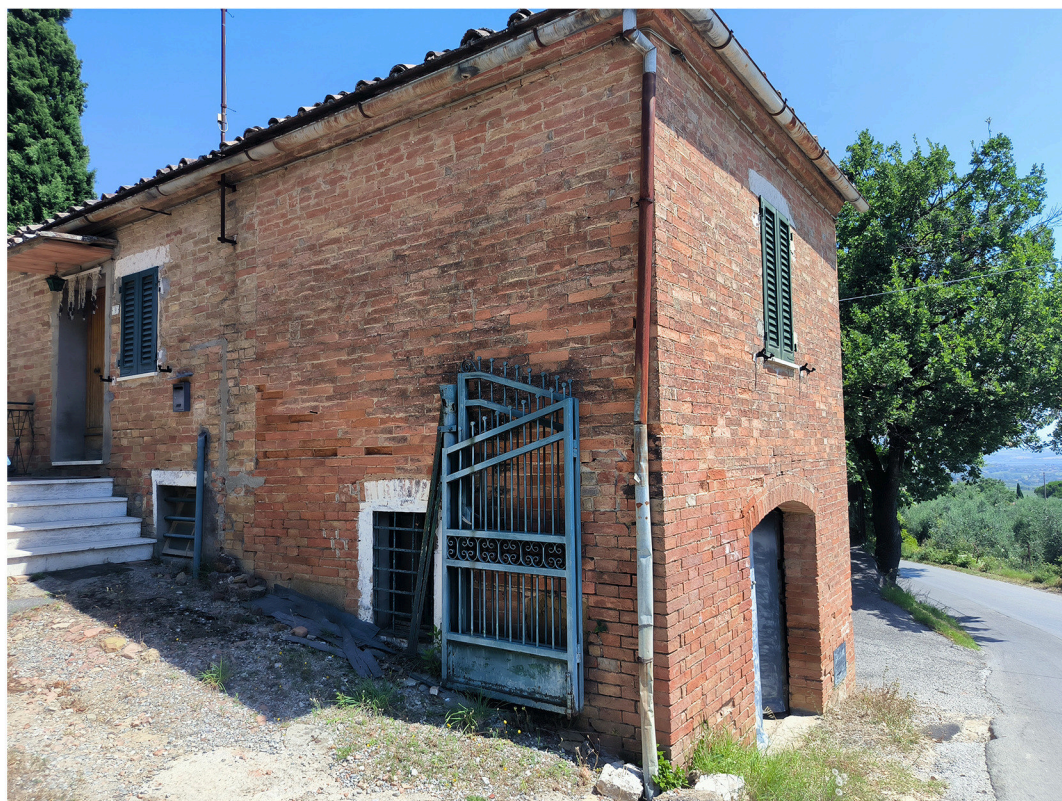
Foto 2 - Abitazione rurale prospetto Ovest e Nord
