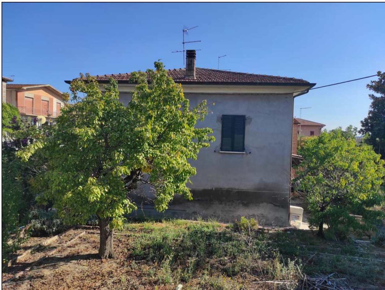
Foto del lato destro del fabbricato (lato sud - porzione della richiedente) posta sotto strada
