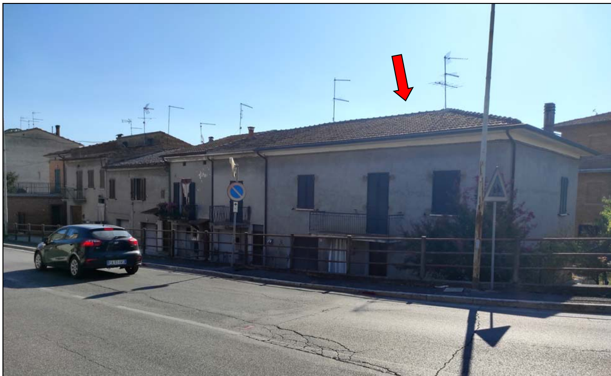
Foto del complesso visto da nord con in primo piano la porzione della richiedente posto sotto il livello stradale
