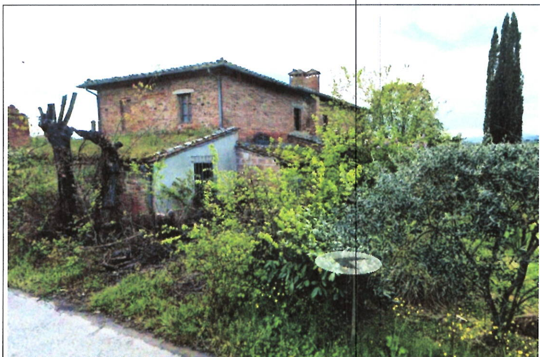
LATO NORD ED OVEST DEL FABBRICATO PRINCIPALE
