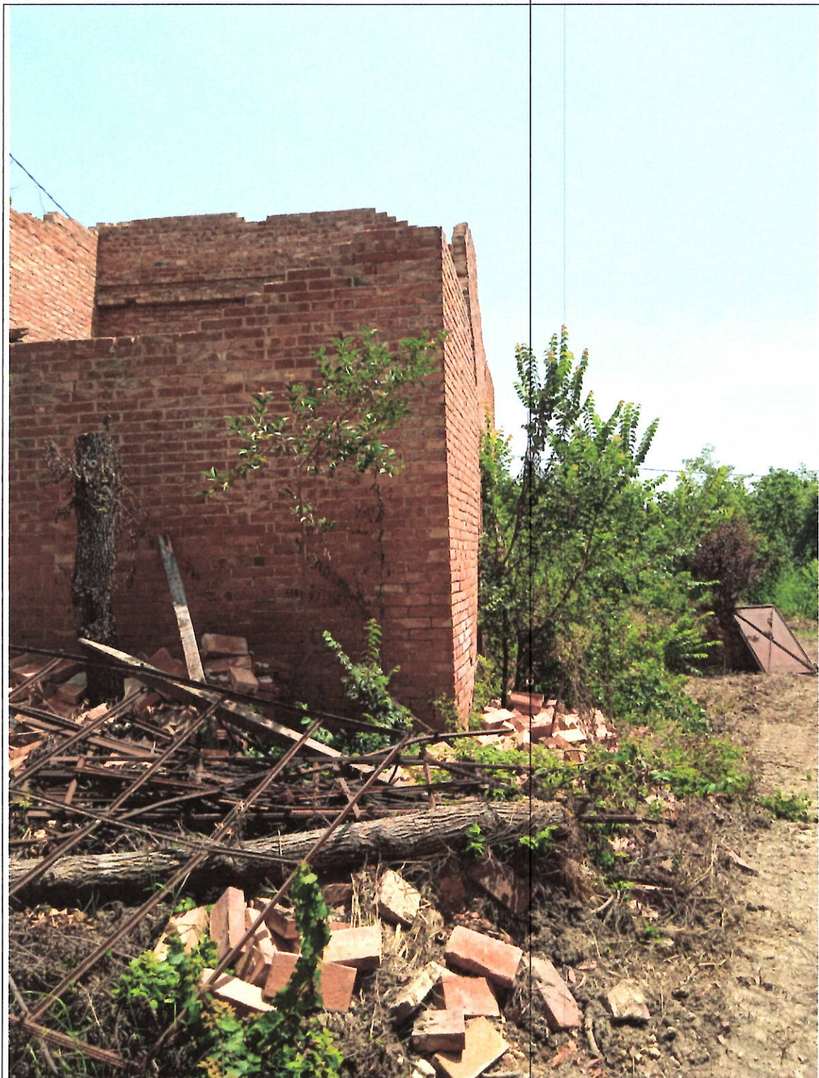
PARTICOLARE RAVVICINATO DEL PROSPETTO LATO EST
