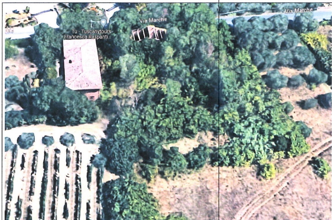
FOTO AEREA DEI DUE FABBRICATI (Si noti la mancanza del tetto dell'annesso crollato da molti anni)
