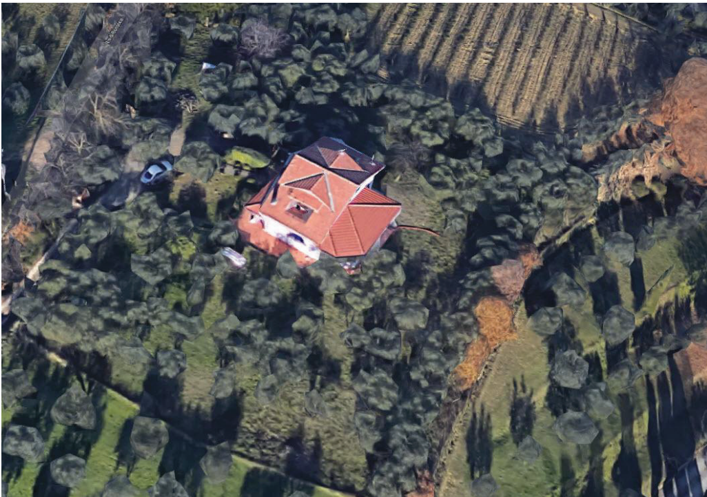
FOTO 8 - Veduta aerea del fabbricato.-
