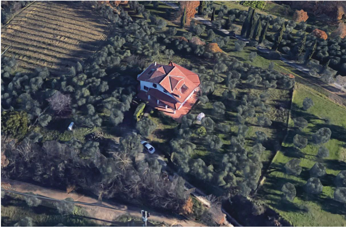
FOTO 5 - Veduta aerea del fabbricato.-
