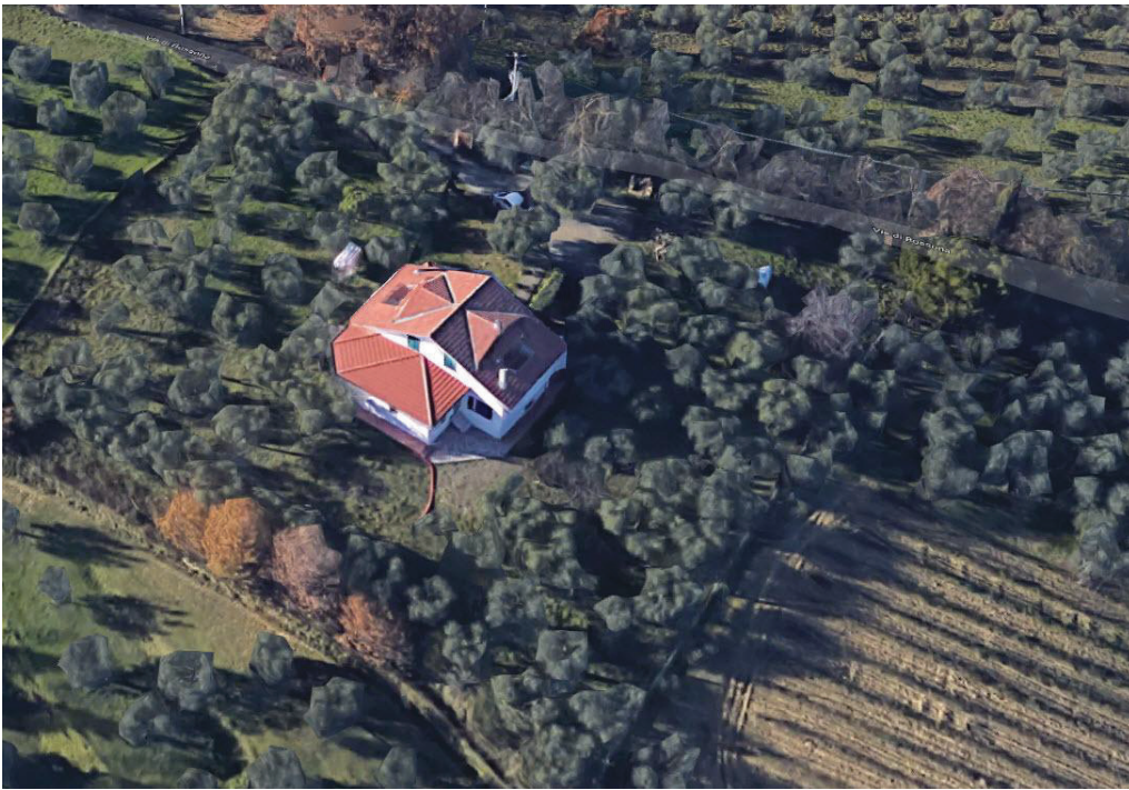
FOTO 7 - Veduta aerea del fabbricato.-
