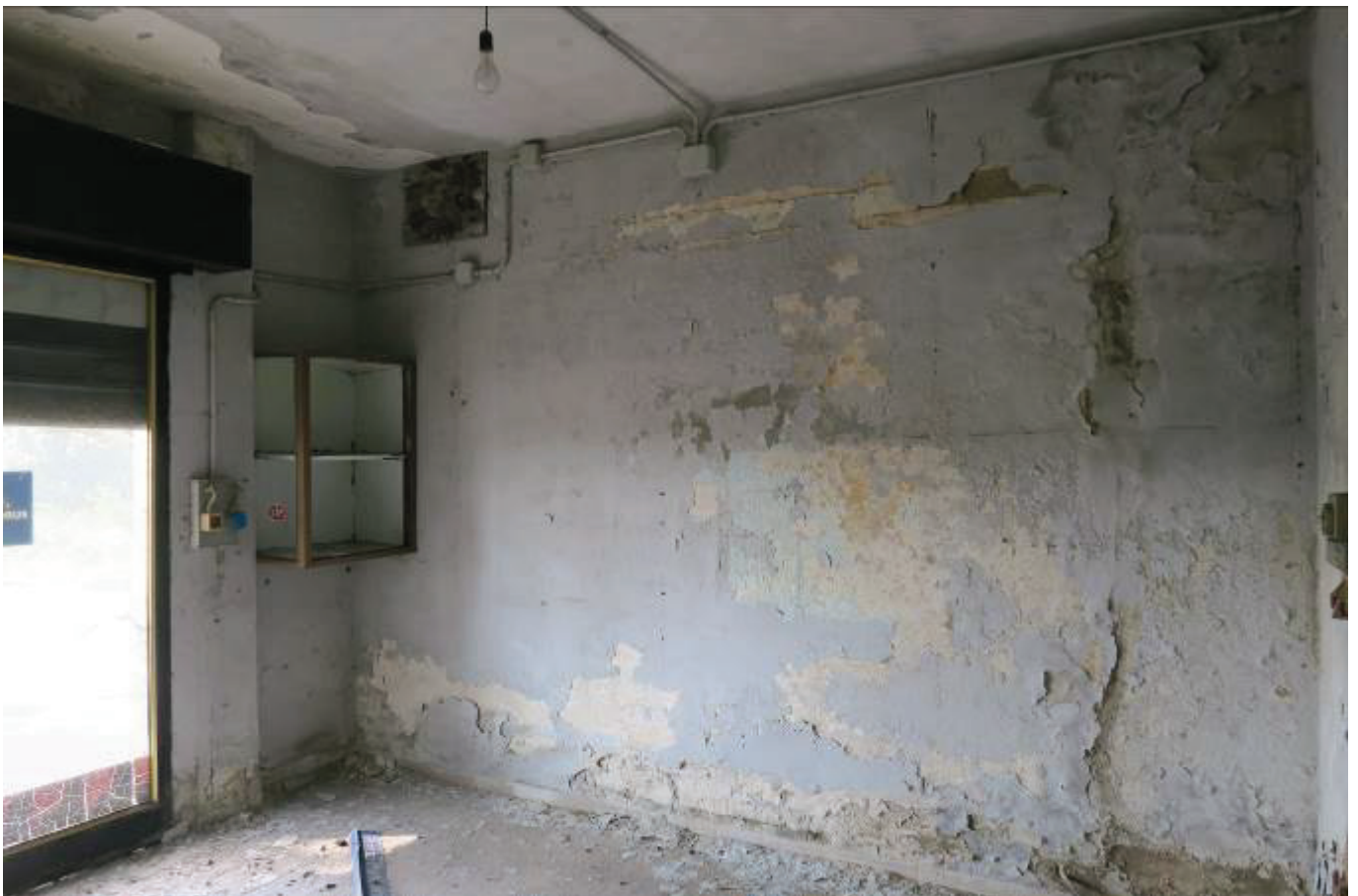
Foto n°05- lo stato dell'ambiente interno
