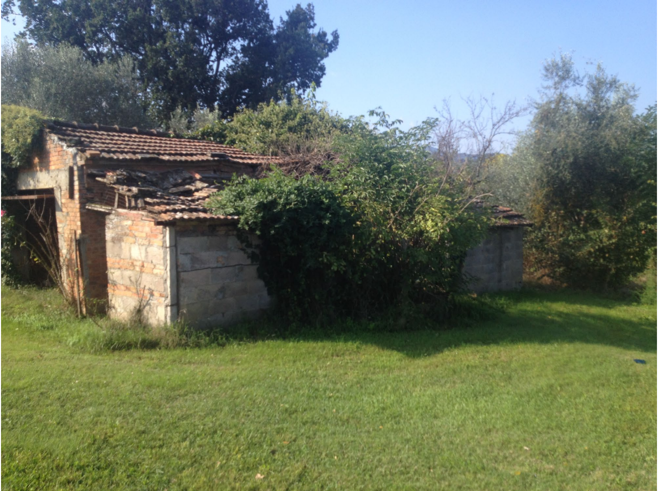
Costruzione in mattoni laterizi e in cemento con coperture in legno e marsigliesi
