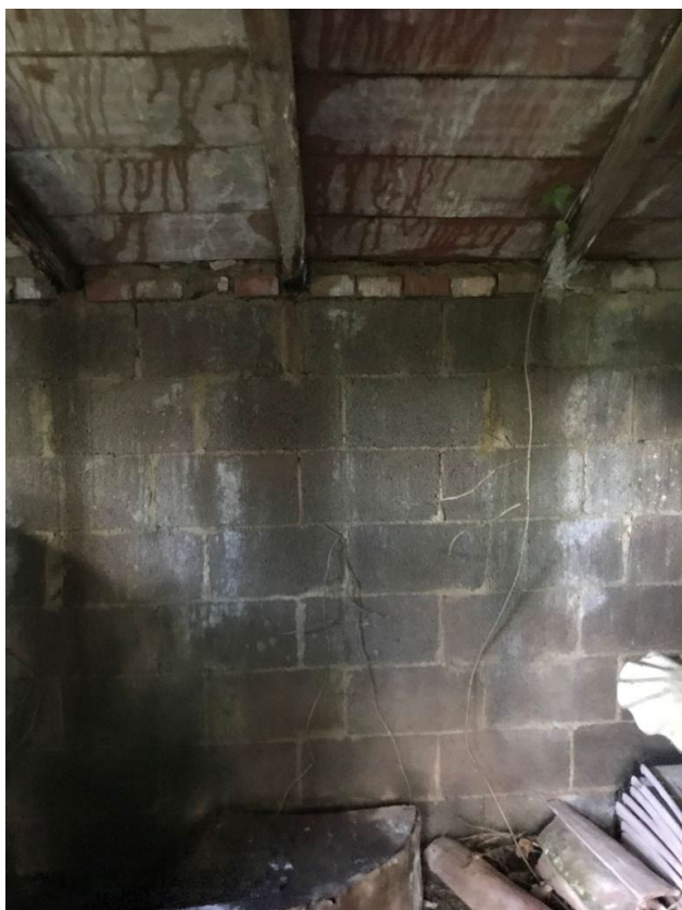
Costruzione in mattoni laterizi e in cemento con coperture in legno e marsigliesi
