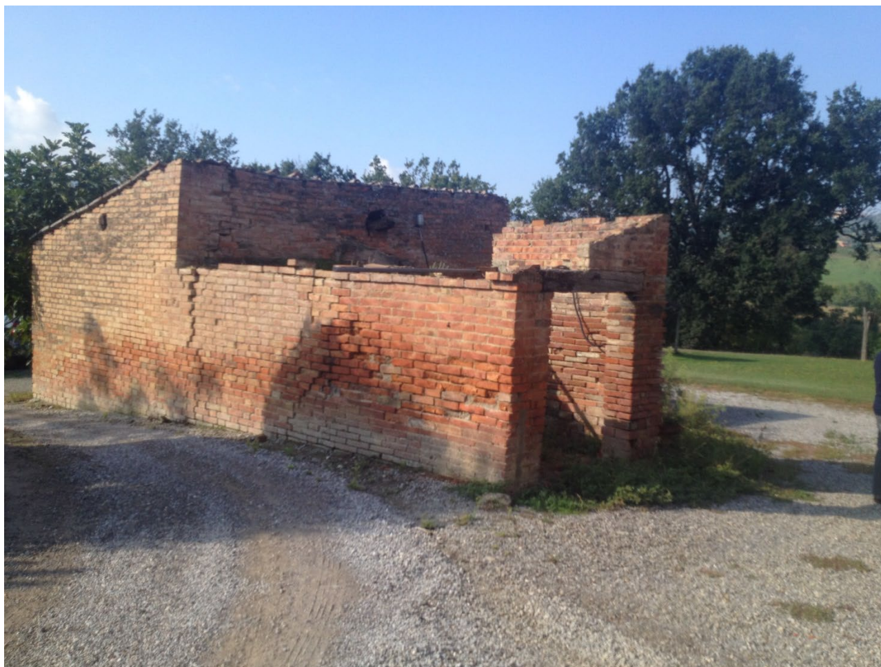
Costruzione in mattoni laterizi con coperture in legno e marsigliesi
