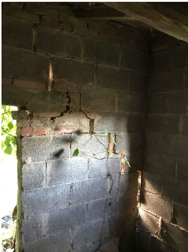
Costruzione in mattoni laterizi e in cemento con coperture in legno e marsigliesi
