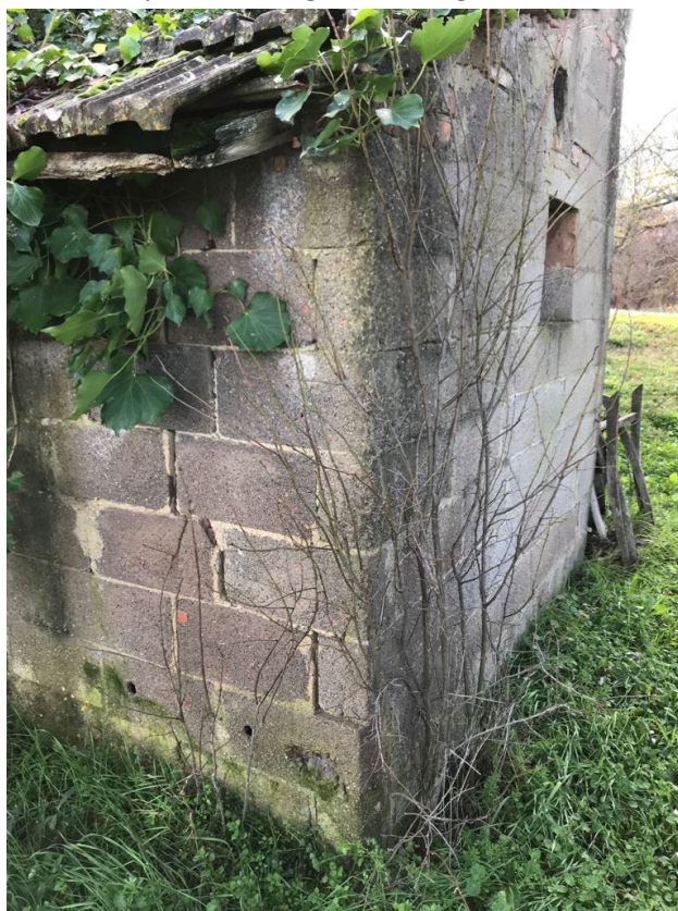
Costruzione in mattoni laterizi e in cemento con coperture in legno e marsigliesi
